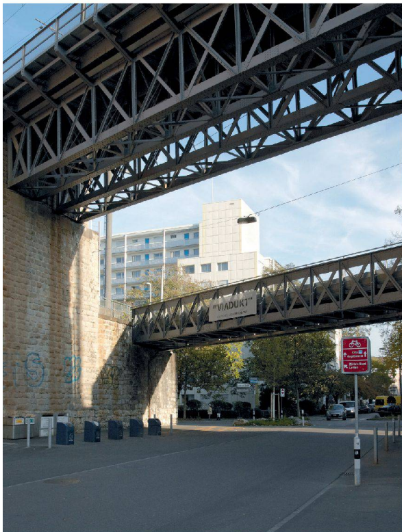
^Über den hohen Viadukt brausen die Züge, die untere Brücke dient dem Fussgänger- und Veloverkehr.
