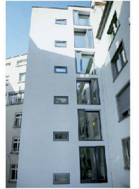
<4_Geschäftshaus Blumenbergplatz, Attikageschoss.
