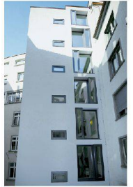
<4_Geschäftshaus Blumenbergplatz, Attikageschoss.
