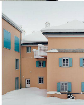
42 _ Neubauten im Dorf Pontresina. Foto: Rasmus Norlander
