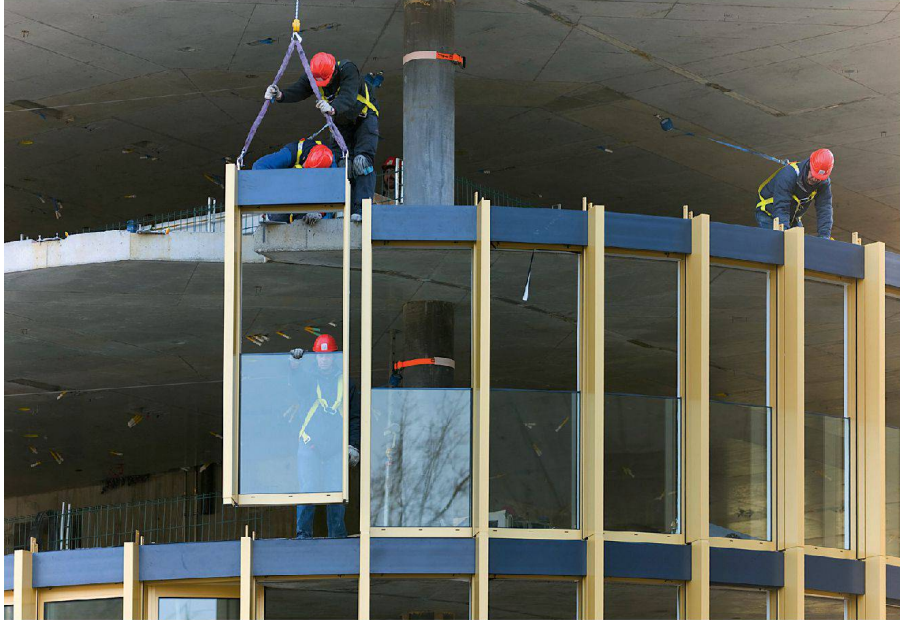
^Montage am Abgrund: Die Bauarbeiter platzieren die Fenster ohne Gerüst.
