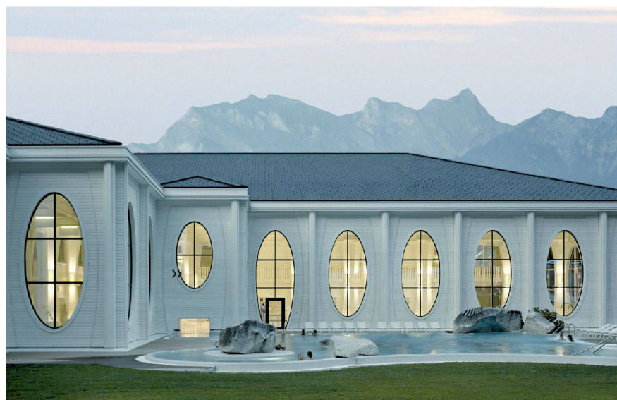
<3_Minergie-Fassadenelemente mit Tannenzholzverkleidungen in Verkehrsweiss, im Werk samt Gläsern zusammengebaut. Foto: Roland Bernath
