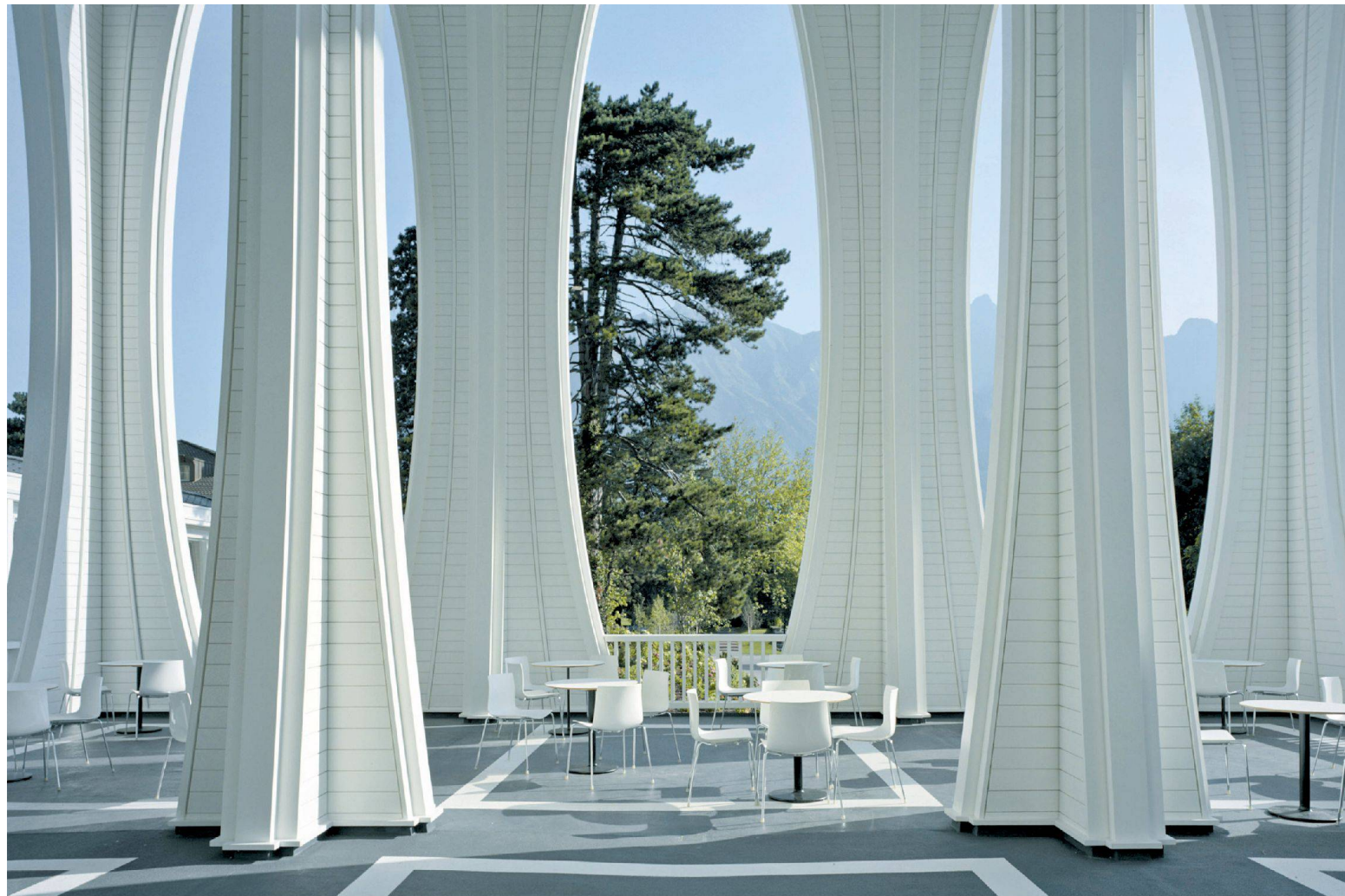
^3_Das Café der Tamina Therme in Bad Ragaz unter den zwölf Meter hohen Holzsäulen. Foto: Roland Bernath
