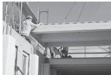
v ... und in fünf Minuten verlegt.
