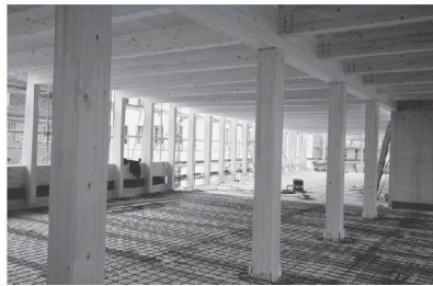
^... zusammen mit der vor Ort gegossenen Holz-Beton-Verbunddecke.
