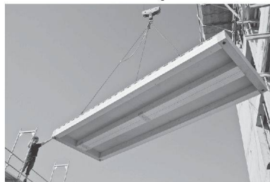
v Ein Deckenelement wird angeliefert ...
