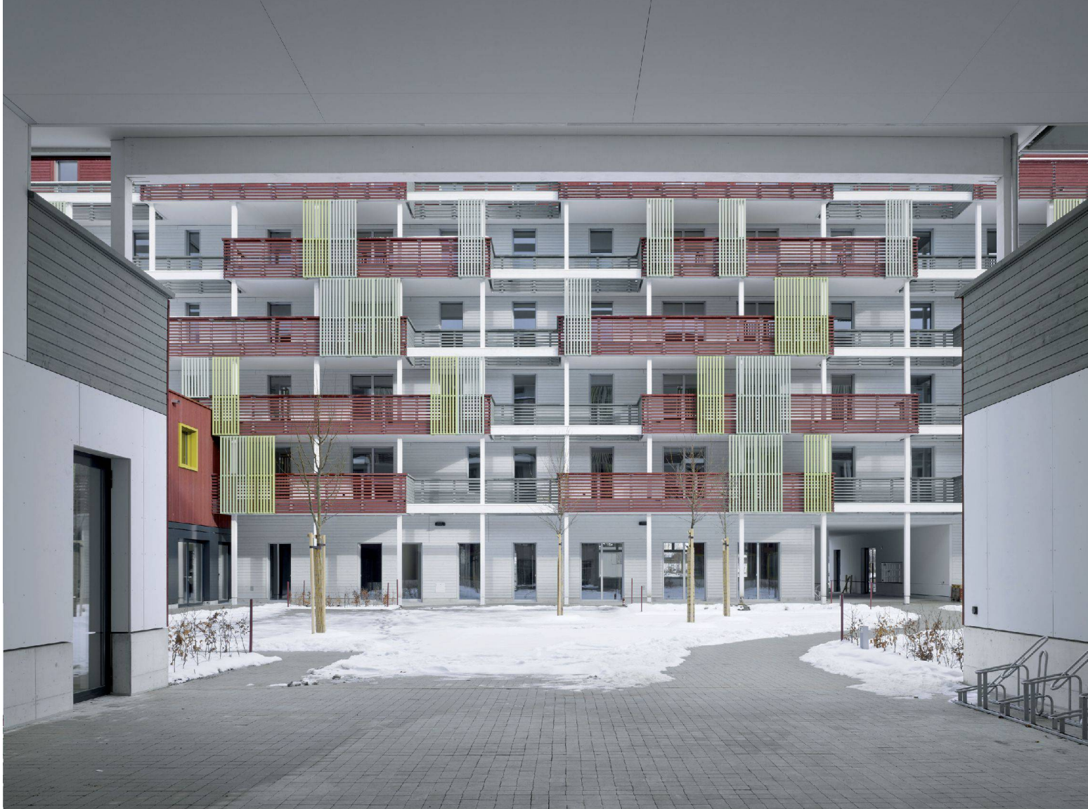
^Die Farbgestaltung steigert die Tiefenwirkung der Loggiafassaden: vorne warme Farbtöne, hinten kalte.
