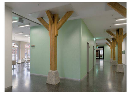
^Der alte Stützenwald prägt die Geschosse im Altbau.
