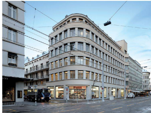
>Das Geschäftshaus an der Zürcher Seefeldstrasse ist mit seinen Fensterreihen ein typischer Bau seiner Zeit.
