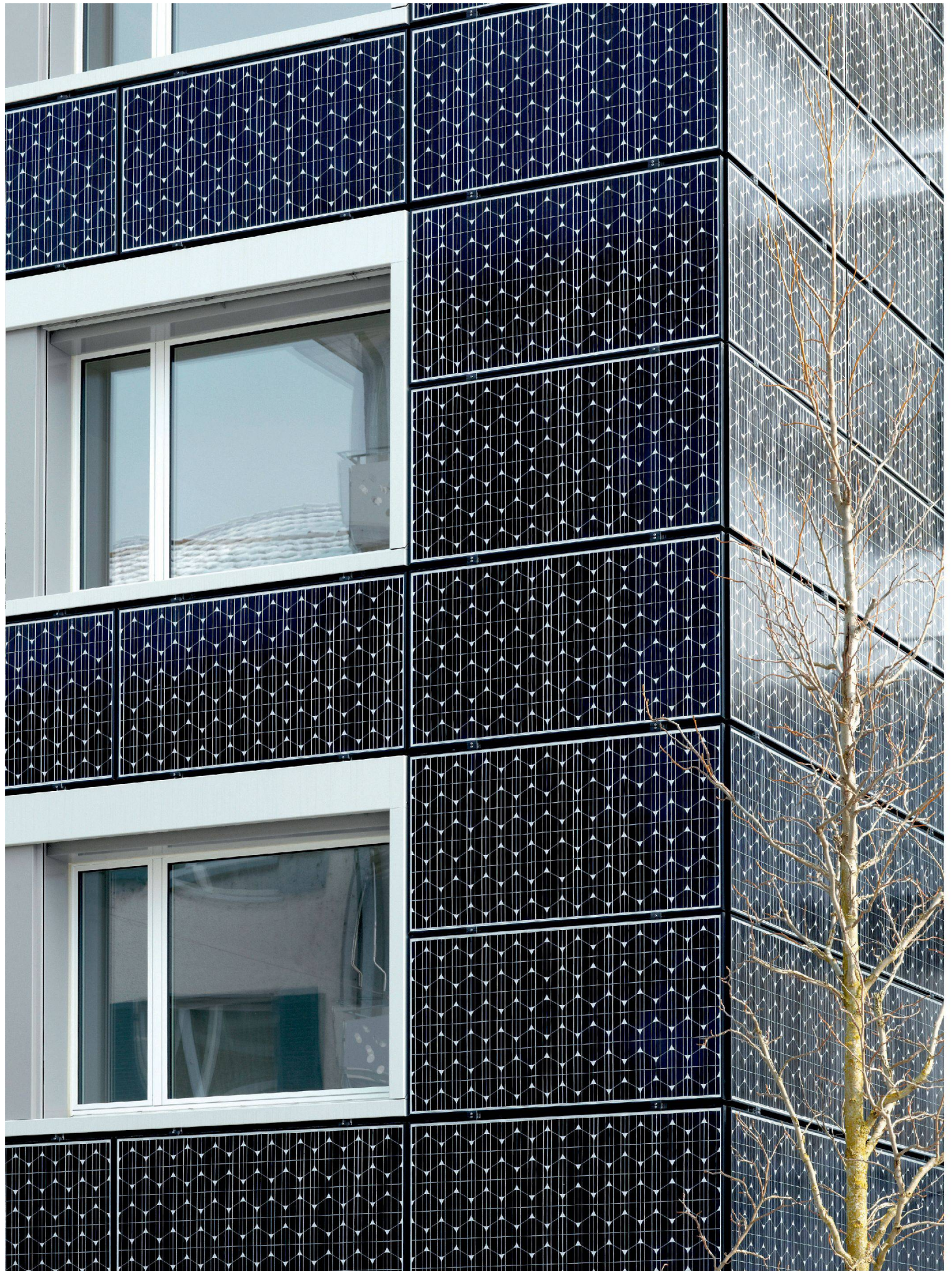
^Effizienteste Fotovoltaikmodule, ein Format – die unflexible Solartechnologie findet in Romanshorn ihren architektonischen Ausdruck.
