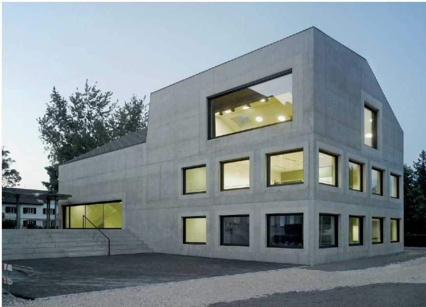
Der Erweiterungsbau der Schulanlage Balainen in Nidau setzt einen zeitgenössischen Akzent neben dem Altbau.
