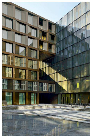
Der Übergang von Chipperfield zu Gigon / Guyer ist bloss ein Tapetenwechsel.
