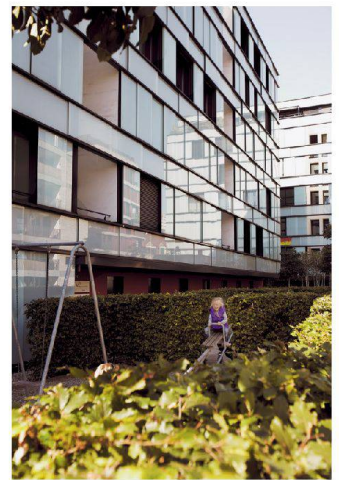
Die verschiebbaren Gläser erzeugen ein wechselndes Fassadenbild.
