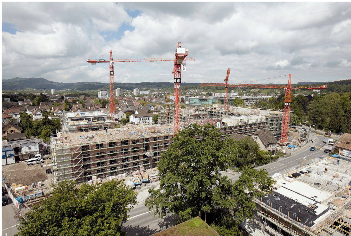
Hier trainierten einst römische Legionäre, heute entsteht auf der Fehlmannmatte in Windisch eine urbane Überbauung.
