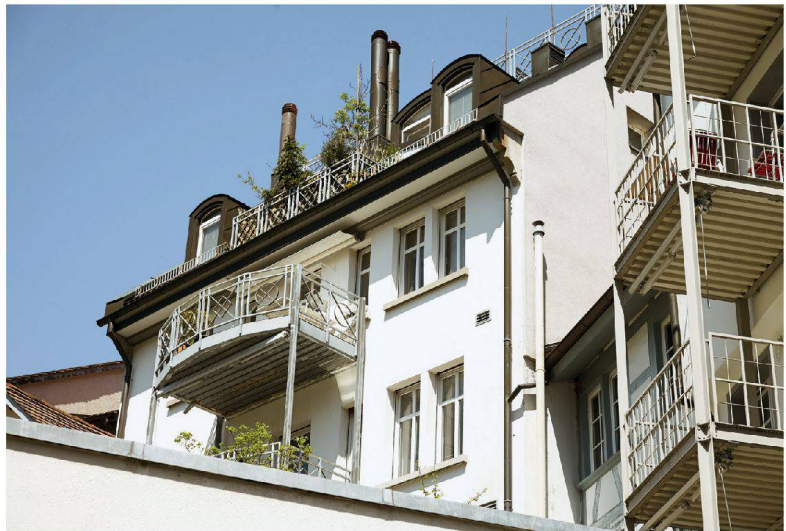
Sanierung Spisergasse, St. Gallen, 1988. Architektur: Senn.
