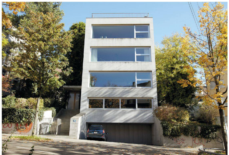
Überbauung Blümlisalpstrasse, Zürich, 2003. Architektur: Pascale Guignard und Stefan Saner.
