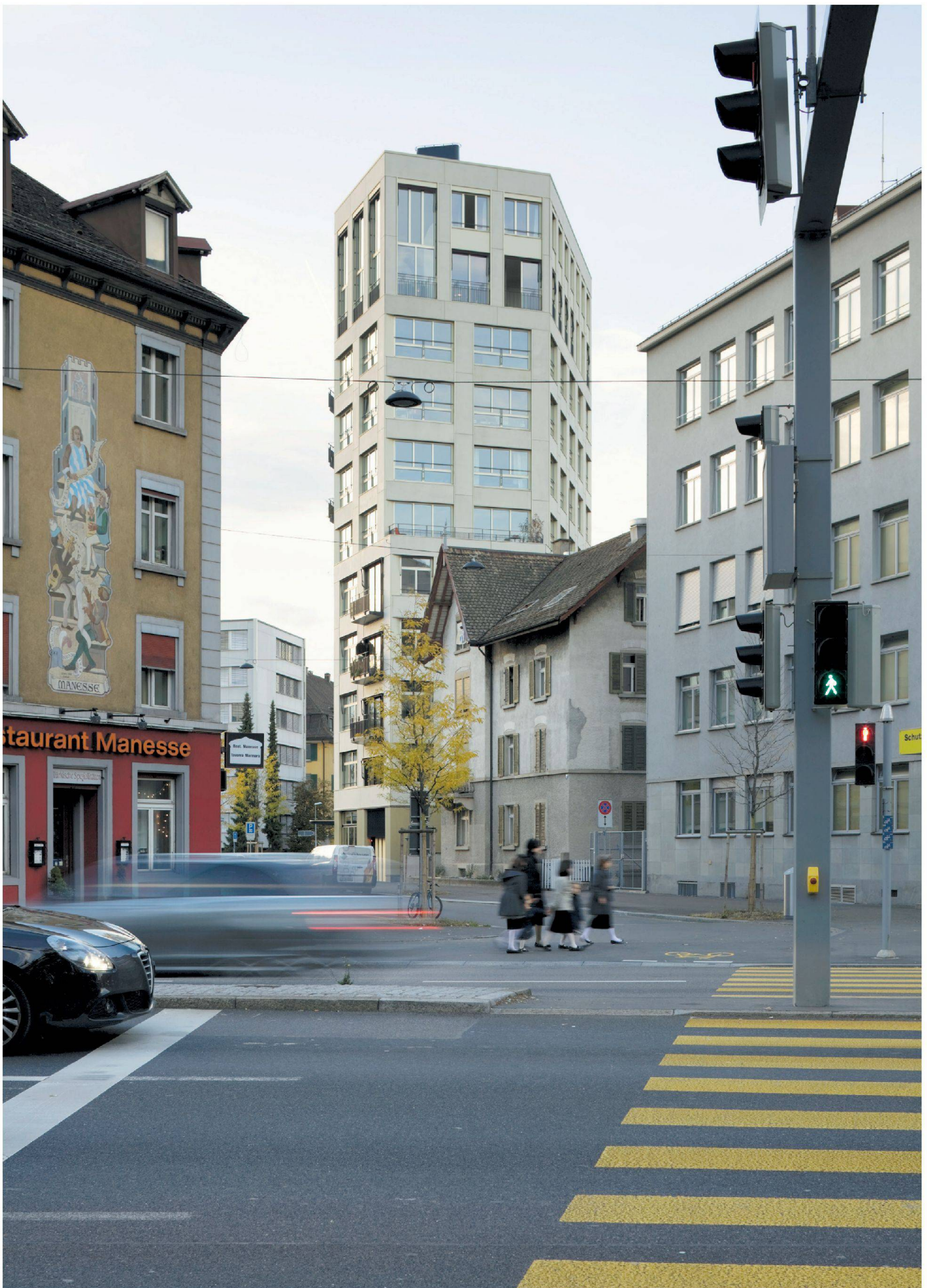
Mit seiner unregelmässigen Grundform und der Gliederung seiner Höhe fügt sich das Haus in die vorhandene Stadt ein.
