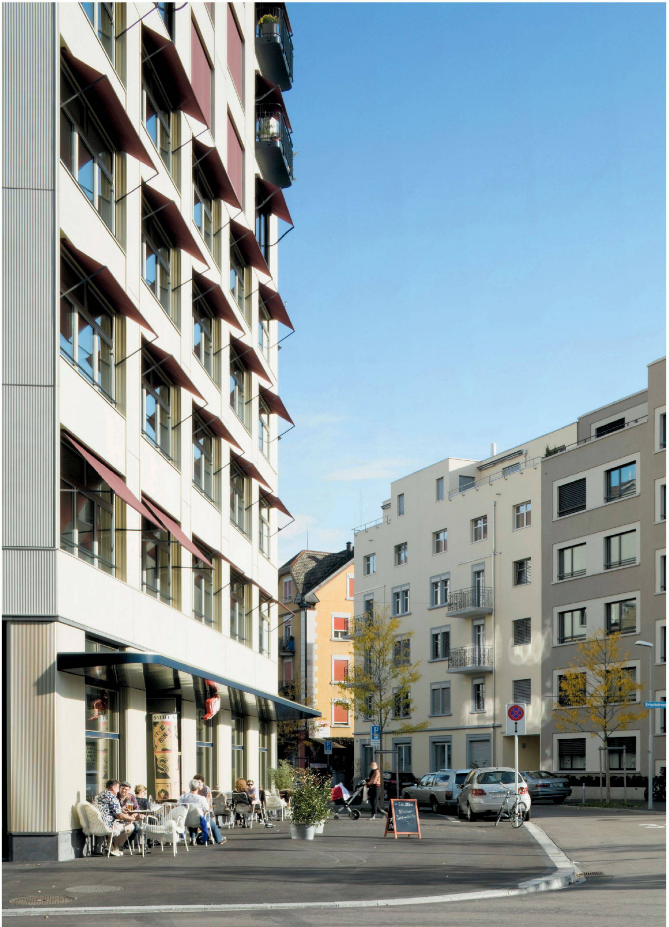
Aus dem Parkplatz wurde ein Platz: Ein von den Architekten gestaltetes Café sorgt für Leben.
