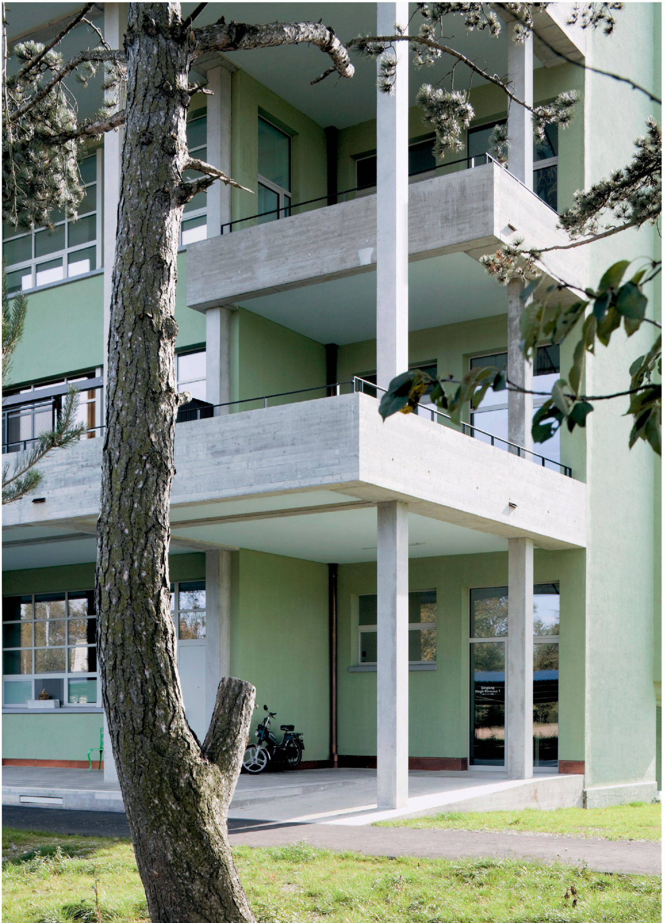
Ebenso pragmatisch und radikal wie die alte Fabrik: Das neue Betonregal vor der Nordfassade nimmt die Laubengänge auf und die privaten Aussenräume.
