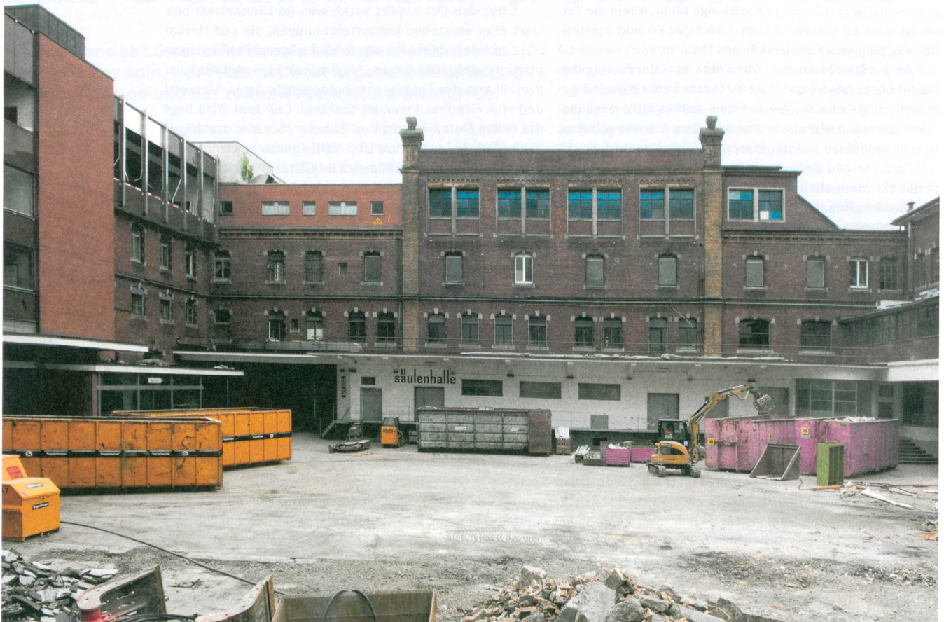
Der Brauereihof im Herbst 2010: Die Bauteile der Siebzigerjahre links werden abgebrochen. Foto: Thomas Zwysig
