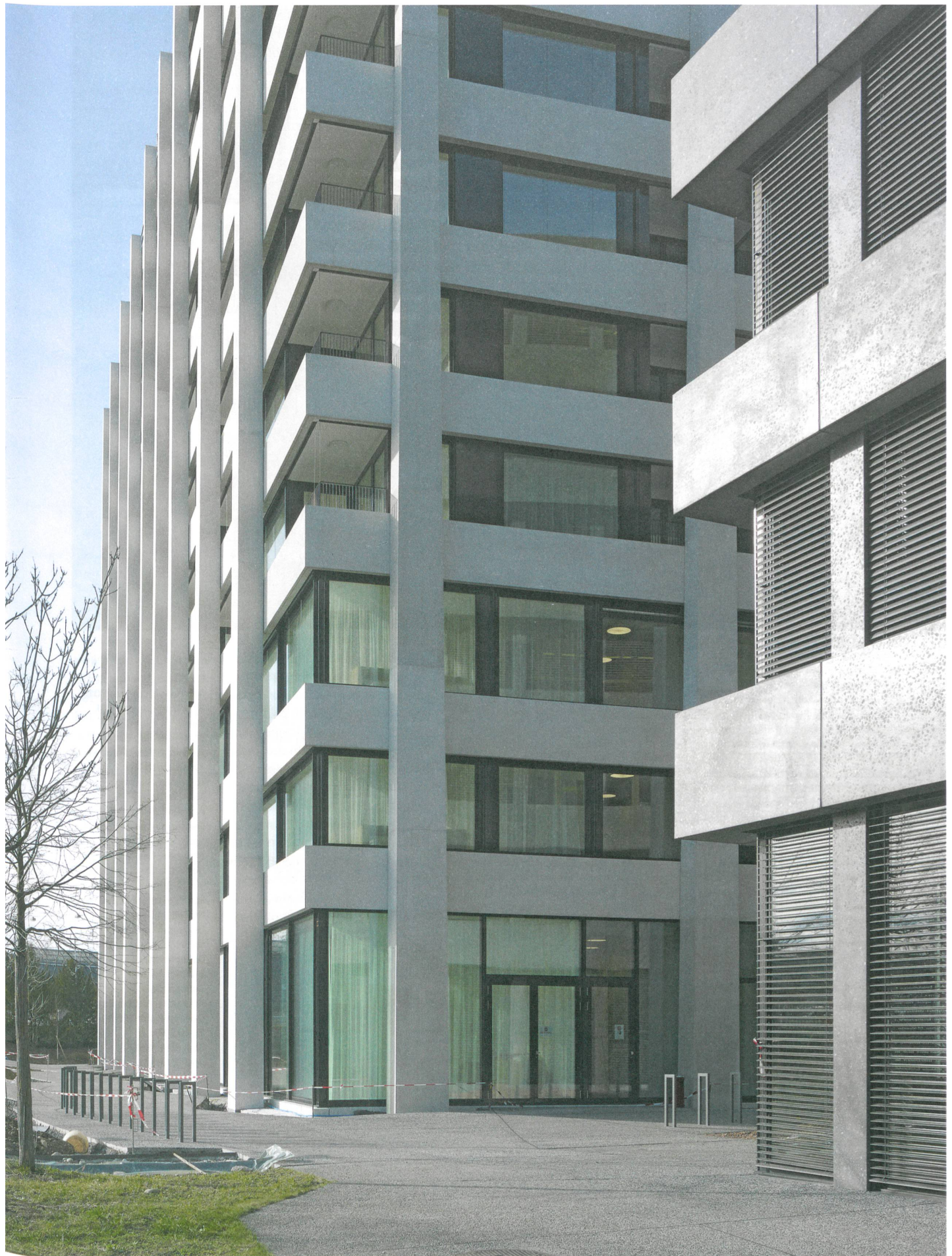
Mehr Ahnung als Wahrnehmung: Man muss schon genau hinsehen, um zu erkennen, dass die Stützen unterschiedliche Formen und Abstände haben.
