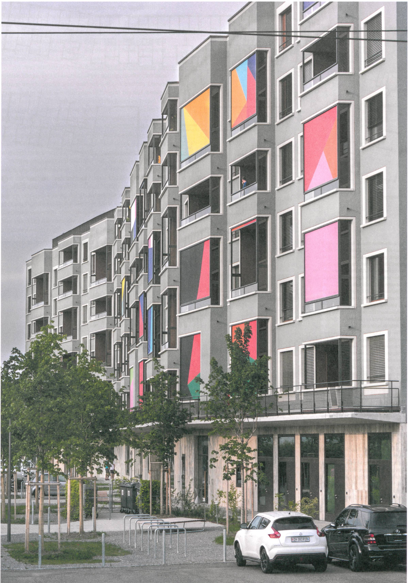
«Kampf gegen den Hasenstall-Effekt»: Risalite aus überhohen Loggien mit farnefrohen Storen der Künstlerin Shirana Shabazi gliedern das Studentenwohnhaus in Zürich-Affoltern.
