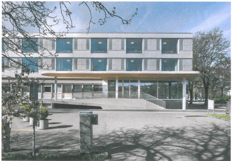
Klinik Lengg in Zürich-Riesbach: Mit abgerundeten Kanten und gelber Untersicht löst sich das Vordach vom Baukörper. Treppe und Rampe mit verspielten Geländern führen ...
