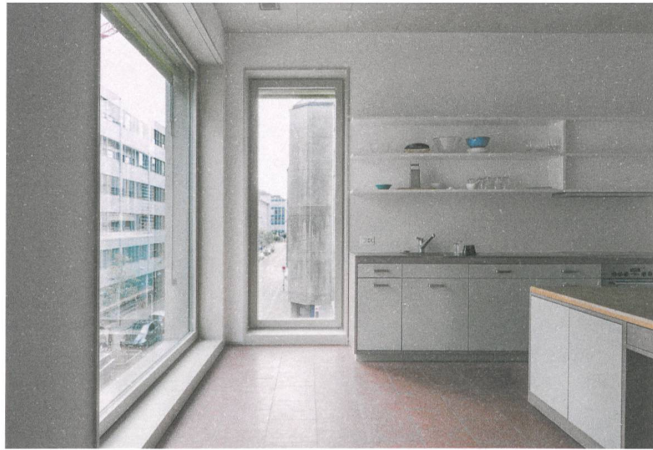
Sichtbetondecken und Kunststeinböden widerstehen dem Studententreiben, Öffnungen in der Brandwand erlauben den Blick in die Tiefe der Zürcher Militärstrasse.
