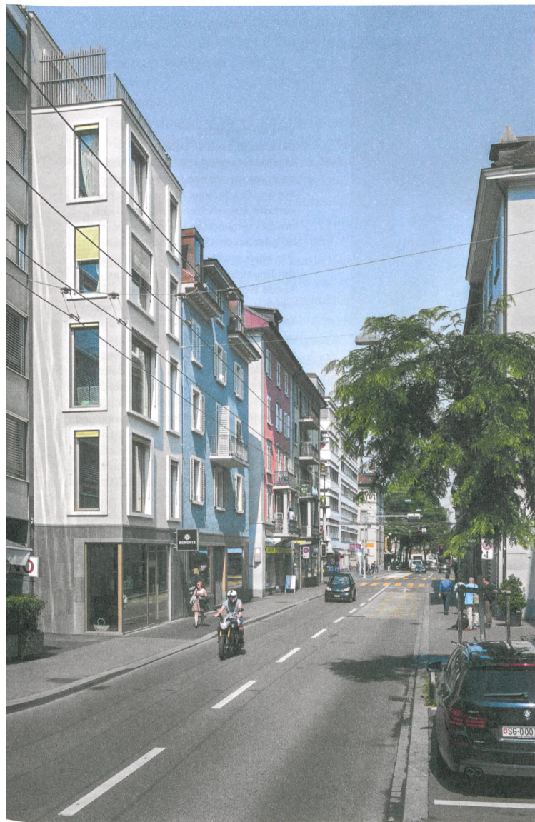
Im weiss verputzten Anbau weichen grosse und frei angeordnete Fenster die Regeln des graublauen Bestands auf, der durchgehende Basaltsockel verwischt die Grenze.
