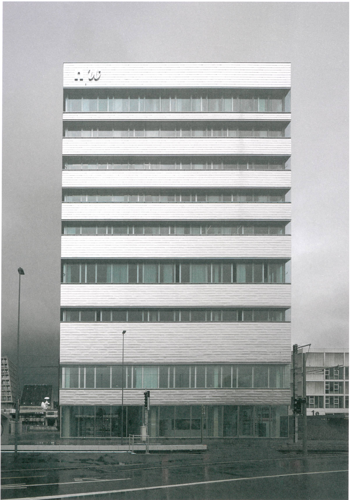
Der Turm spielt einen Platz frei und setzt an der Strasse ein Zeichen für die Bildung. Foto: Valentin Jeck
