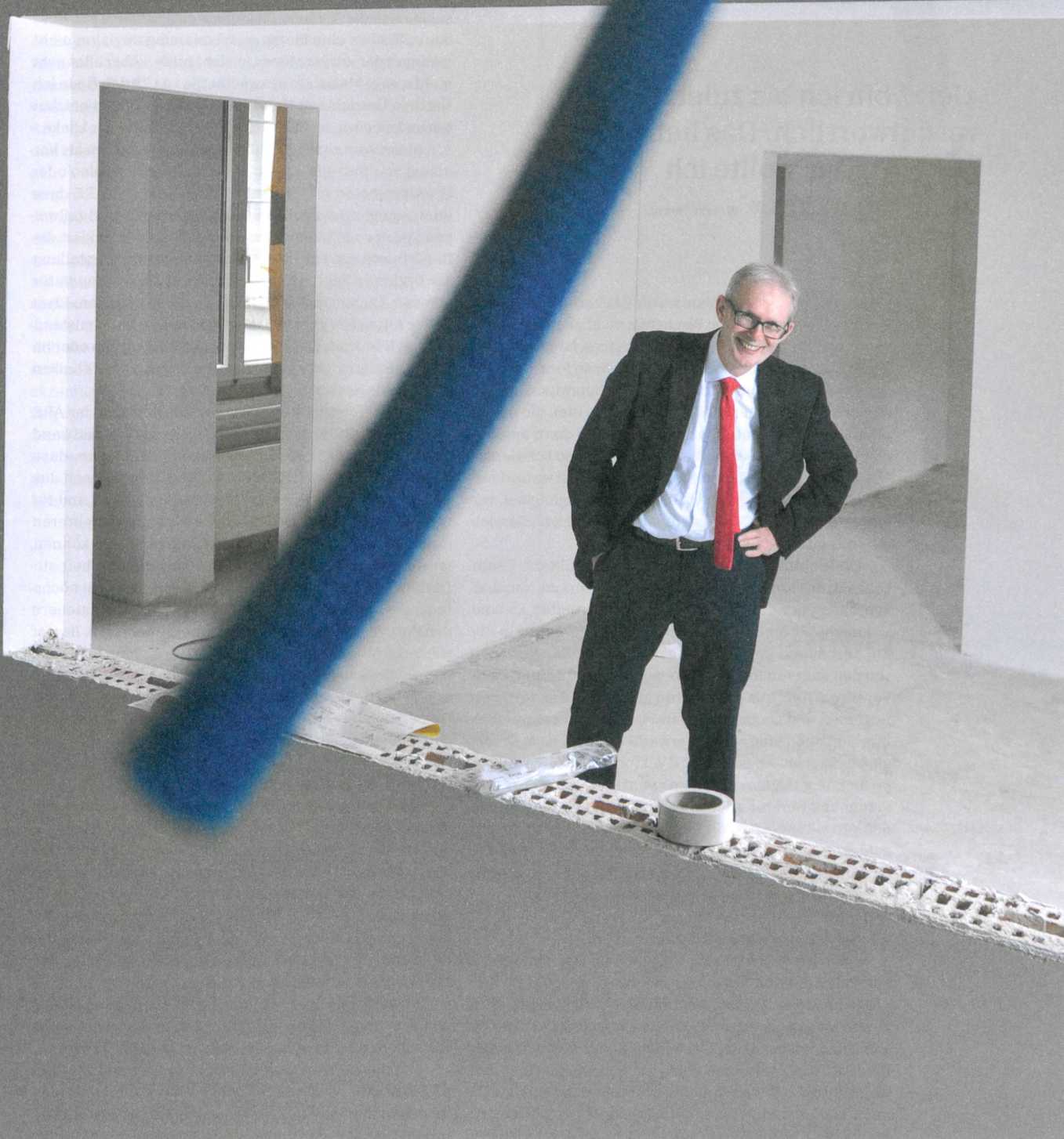
Wilhelm Natrup auf der Baustelle der neuen Büros des Zürcher Amts für Raumentwicklung. Die Lust an der Arbeit ist dem Kantonsplaner anzusehen.
