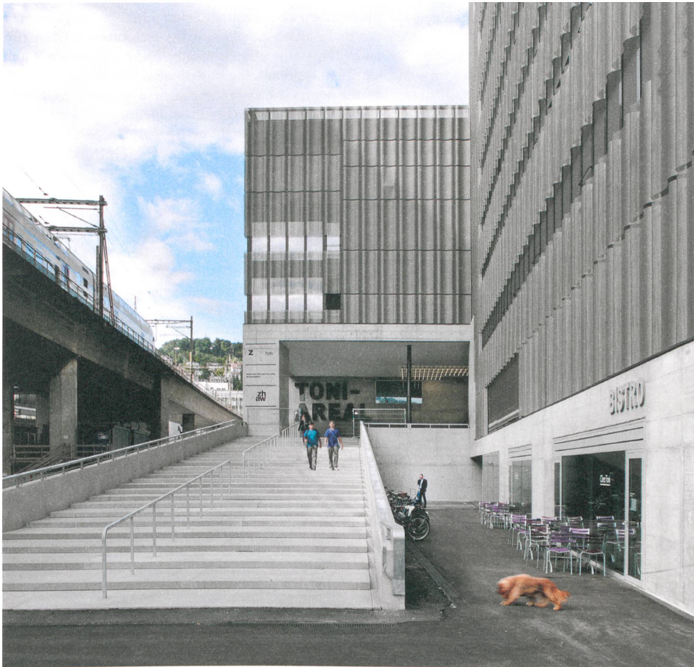
Komm herein: Eine wuchtige Freitreppe führt die Besucher von der Tramhaltestelle zum Eingang.
