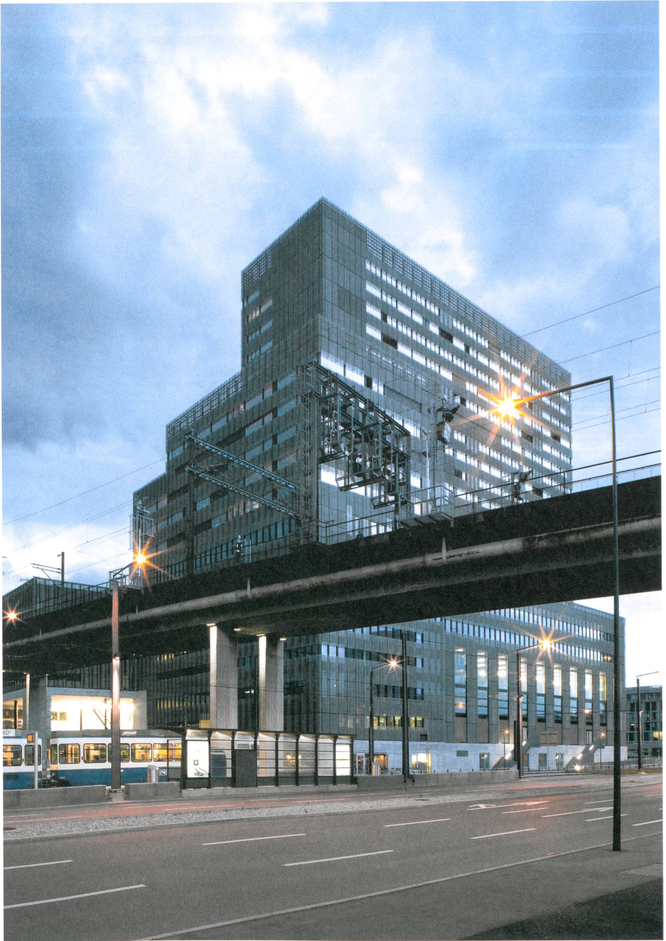
Zwischen Bahnviadukt, Autobahnzubringer und Tramachse: 22 Stockwerke hoch türmt sich der Campus Toni-Areal in den Abendhimmel von Zürich West.
