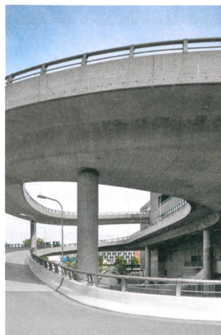
Die Lastwagenrampe wird zum Boulevard.
