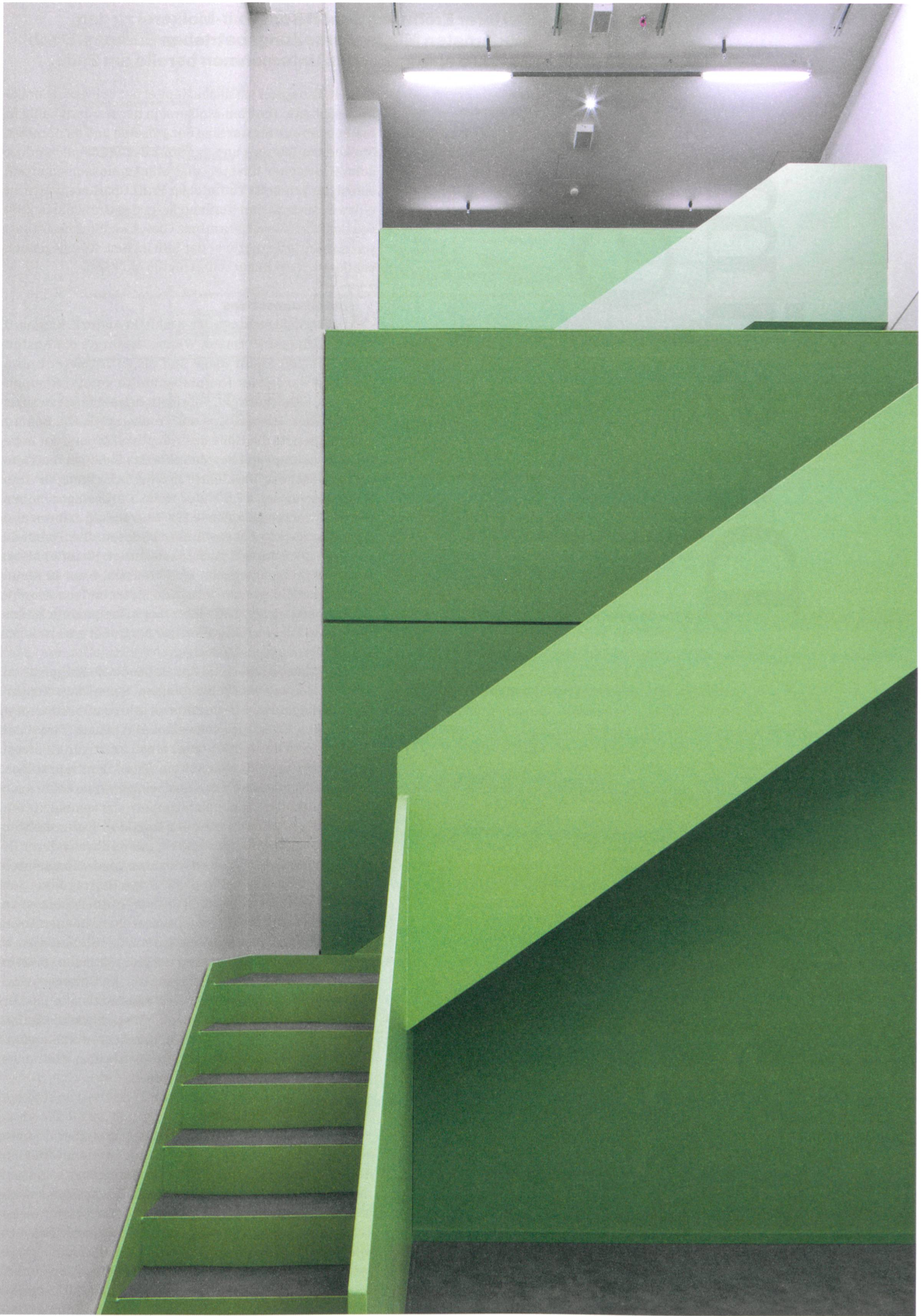
Kleine Kaskade in grosser Halle: Im ehemaligen Trockenturm treppen sich die Arbeitsplätze der ZHAW-Studierenden über drei Geschosse hinauf.
