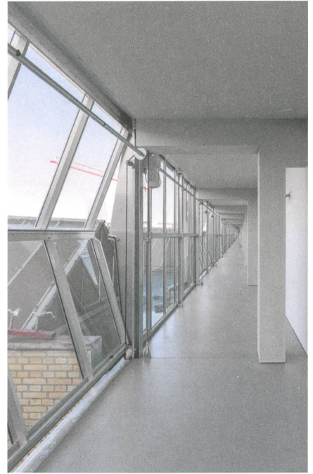
Der Gang im 2. Obergeschoss ist knapp über dem alten Hallendach abgehängt.
