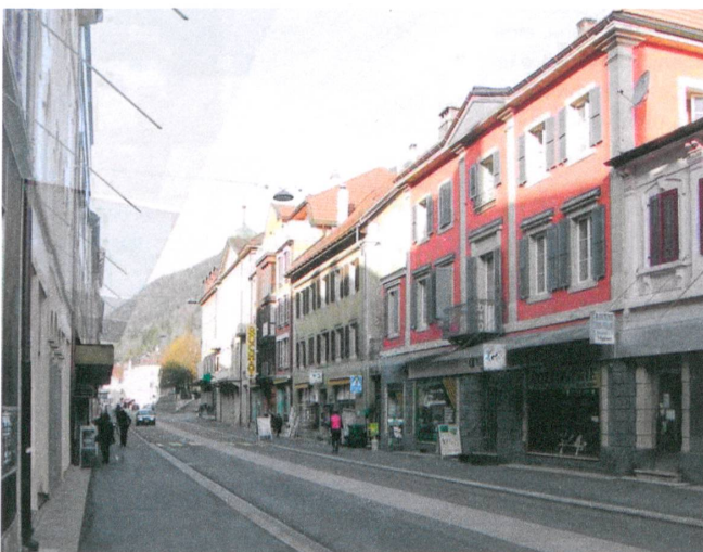
A Saint-Imier, une bande centrale permet de traverser la route cantonale en deux étapes. | Ein Mittelstreifen soll es ermöglichen, die Kantonsstrasse in Saint-Imier in zwei Etappen zu überqueren.
