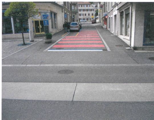
Bandes centrales, bande en pierre naturelle, trottoir continu. | Mittelstreifen, Natursteinband, Trottoirüberfahrt.
