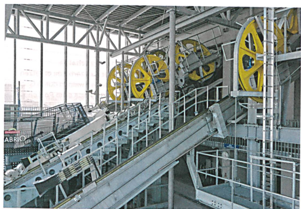
Die Seile der «Cabrio»-Bahn sind viermal schwerer als jene der vorherigen Bahn.
