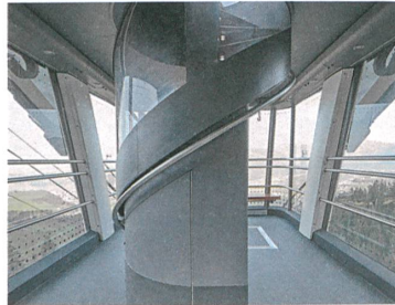
Der Steuerkasten ist in die Wendeltreppe integriert.
