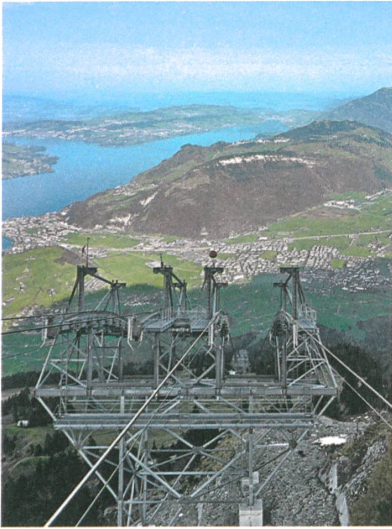
Die Masten am Stanserhorn sind 24 Meter breit.
