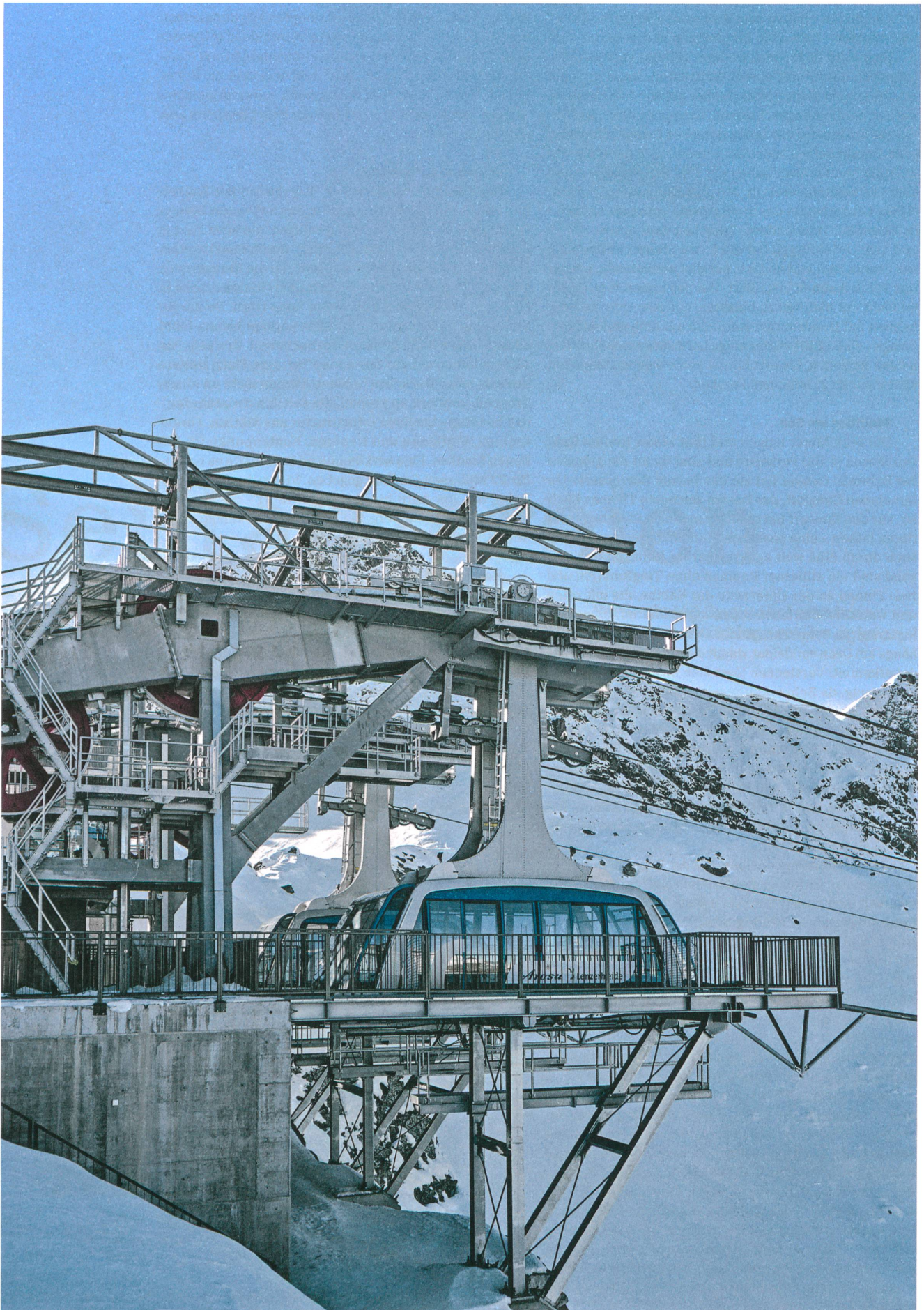
Urdenbahn zwischen Arosa und Lenzerheide: Die zehn Meter langen und fünf Meter breiten Kabinen fassen je 150 Personen und sind damit die grössten der Schweiz.
