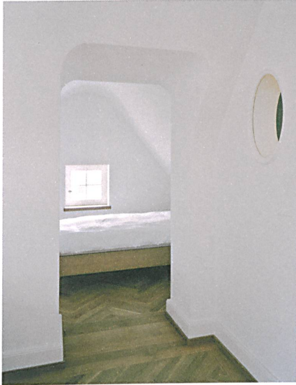
Detailsorgfalt: Fischgratböden, Holzlambrie mit Staubleiste.
