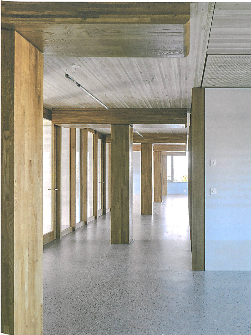
Eigensinnig prägen die Stützen mit Sattelholz die Räume.
