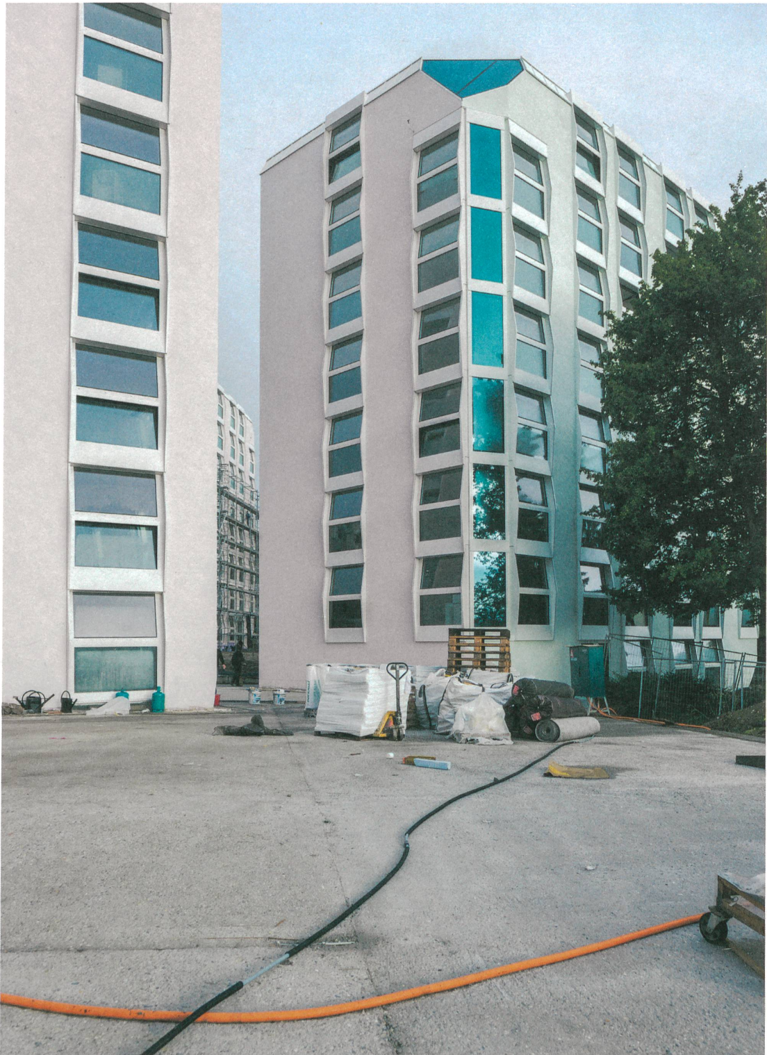
Rautstrasse, Zürich, mit radikaler Repetition: Mehr als 750 gleiche Fensterelemente an sieben identischen Bauten mit immergleichen Wohnungen.
