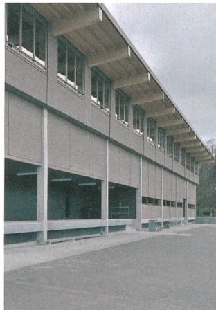
Der Werkhof in Winterthur-Hegi ist ein Familienwerk.
