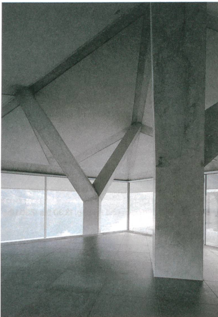
Das Stabwerk aus Dachrippen und leicht asymmetrischen Y-Stützen ist mit vorfabrizierten Elementen vergossen.
