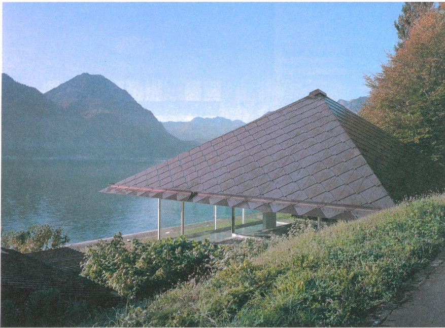
Das Kupferdach des Hauses am Sarnersee wirkt leicht wie Papier und bedeckt eine kräftige Betonschicht.
