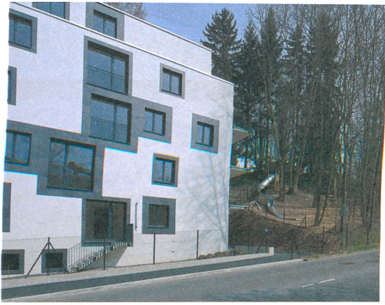
Tribu architectes machen in Lausanne mit verspielter Schwarz-Weiss-Grafik aus einer Aussendämmung eine charakterstarke Gebäudehülle.
