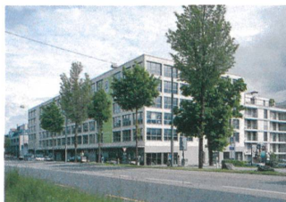
Das Büro- und Ladengebäude an der Murtenstrasse schirmt den Hof ab.
