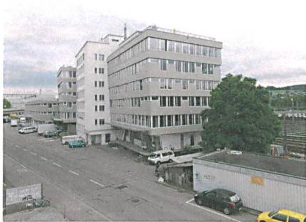
Der Clou der Fassade: Jedes Geschoss kragt 15 Zentimeter über die darunter liegende Etage aus.
