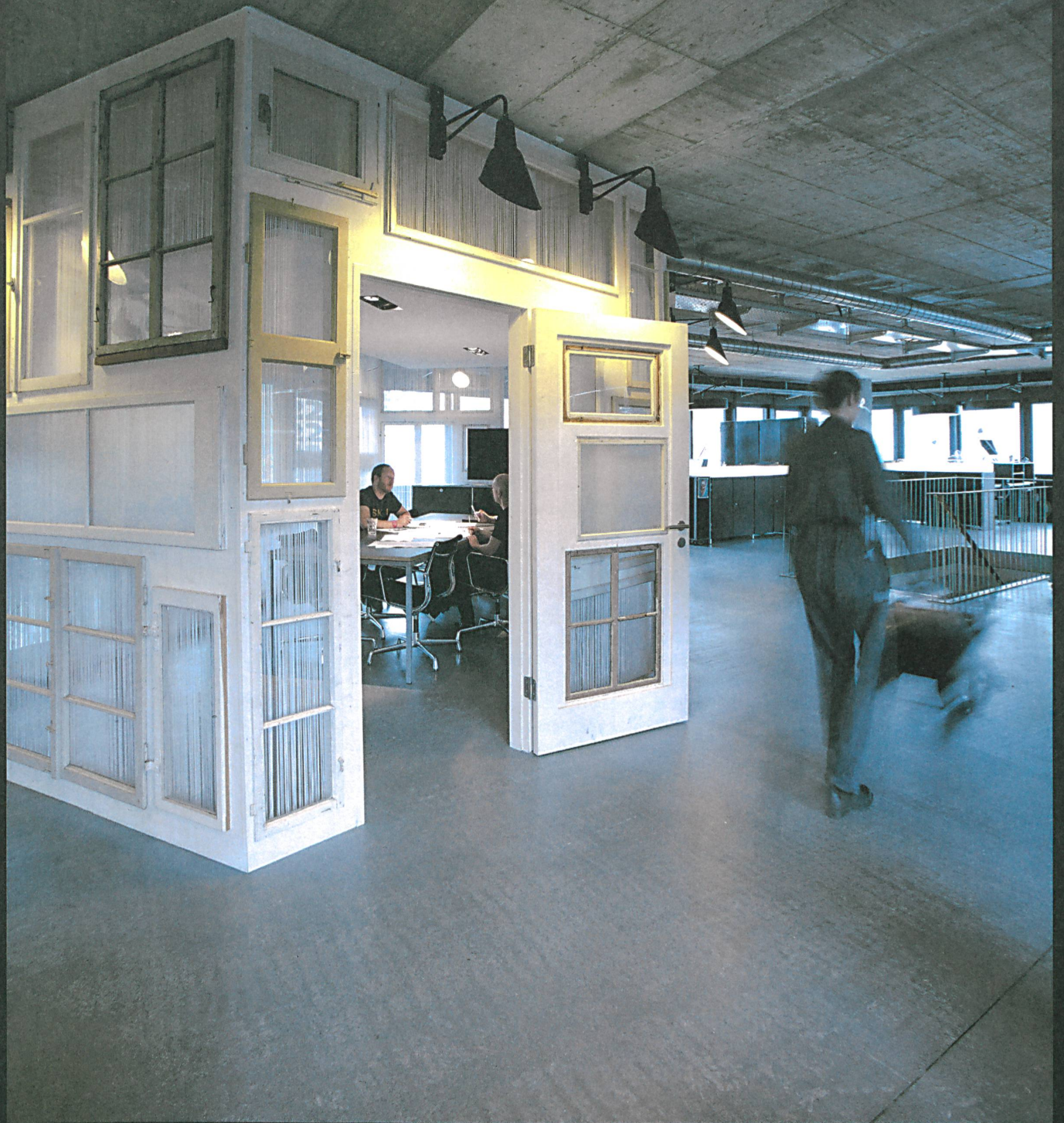
Selbst verfeinern: Das Gewerbehaus Nörd in Zürich siehe Seite 8 ist als Edelrohbau konzipiert, den die Mieter in Eigenregie ausbauen, um Kosten zu sparen.
