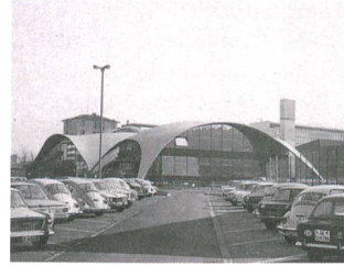
Heinz Islers Betonschalen sind legendär: im Bild die Kuppel für den Feuerlöschfabrikanten Sicli in Genf, erbaut 1969. Foto: GTA-Archiv, Nachlass Heinz Isler
