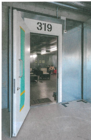
Rohe Architektur: Die Installationen liegen sichtbar, die Wände sind unverputzt.
