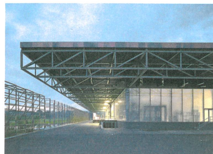
4 Erweiterung Fensterfabrik Baumgartner, Hagendorn
