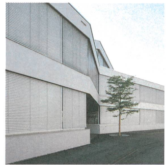
Die Fassadenknicke weisen den Weg zum Eingang.
