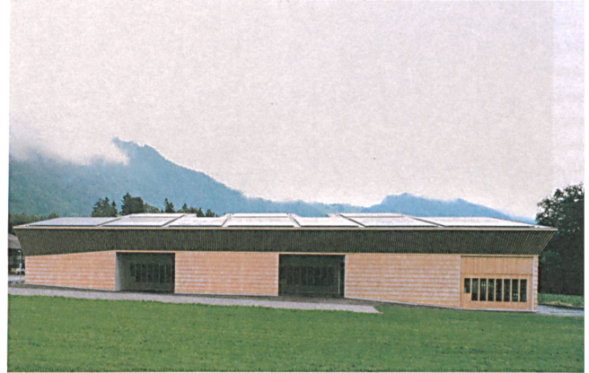
Fotovoltaikpaneele sammeln auf dem Dach fast unbemerkt Strom.
