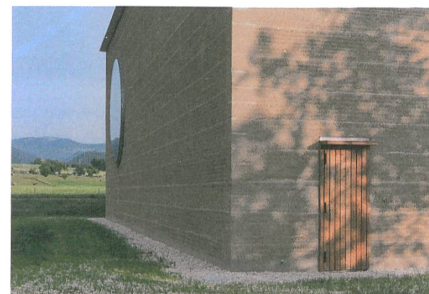
Horizontale Schichten aus Trasston verhindern, dass die Fassade zu stark erodiert.
