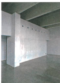
Die Deckenträger zeigen, wie die Lasten ruhen.
