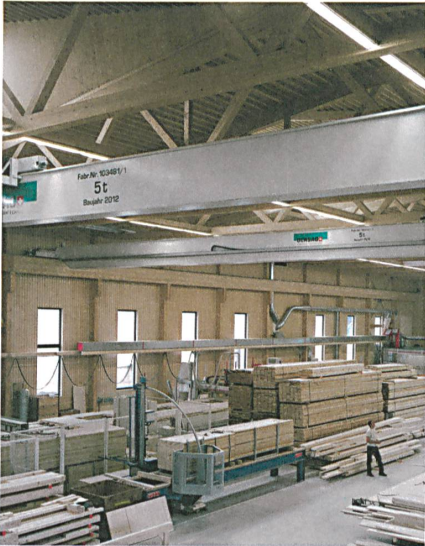
Sogar der Balken, auf dem der Kran ruht, ist aus Holz.
