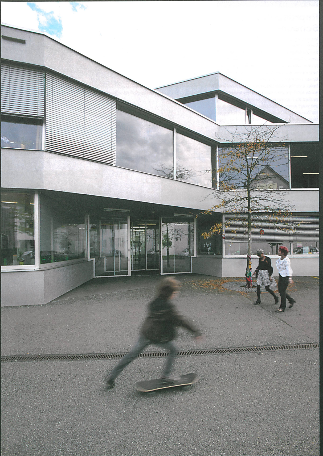
Transparente Gewerbearchitektur: Das Wohnwerk in Basel siehe Seite 32 versteckt sich nicht im Hinterhof, sondern öffnet seine Fassade geknickt nach aussen.
