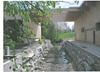
7 Werkhalle Schärholzbau, Grossdietwil
