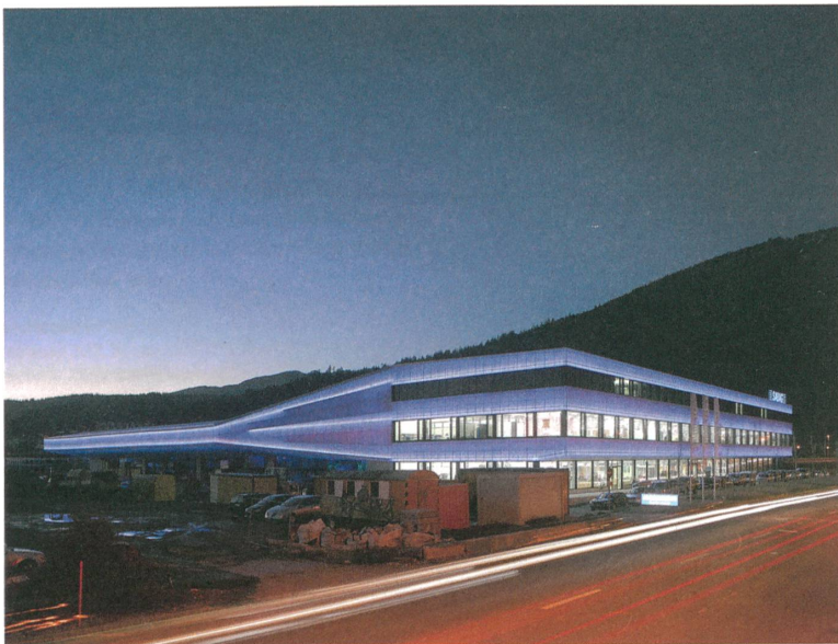
In der Nacht leuchten die Fassadenbänder.
