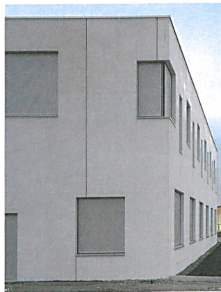
5 Erweiterung Produktionshalle Dosteba, Bachenbülach
