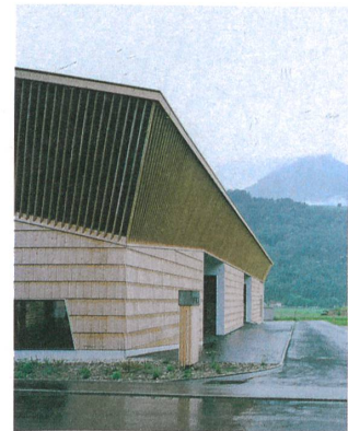
Die Auskragung schützt die Schindelfassade vor der Witterung.
