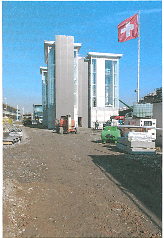
Anders als geplant ist die Konstruktion der Türme nicht in Holz, sondern in Beton realisiert worden. Foto: Network
