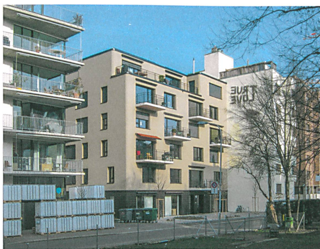
Rechts schliesst das Haus an den Nachbarn an, links blickt man vorbei auf das Gleisfeld.
