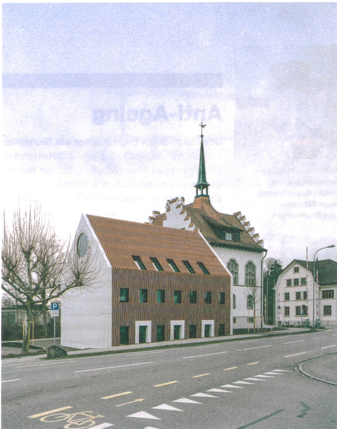
Der Neubau in Münchwilen schliesst direkt an das Gerichtsgebäude von 1906 an.
