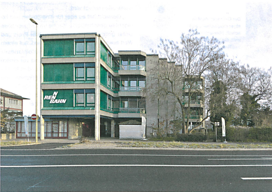
Aus den Büros in Muttenz wurden Studentenwohnungen. Das Restaurant im Erdgeschoss und die Zahnklinik im obersten Stock sind jedoch geblieben.
