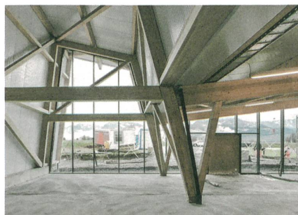
Die Holzkonstruktion gibt der Halle die äussere Form.
