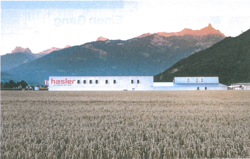
Dank der doppelgeschossigen Bereiche markiert die Hasler-Halle Präsenz in der Ebene von Monthey.
