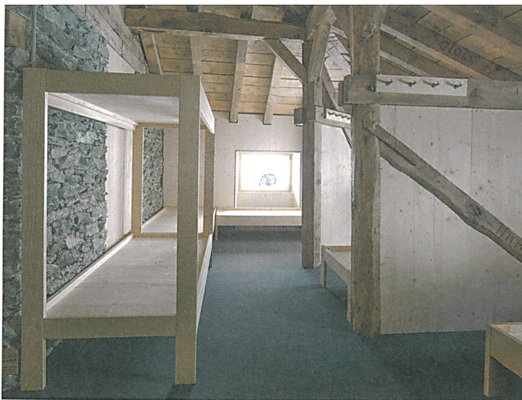
Der Dachstuhl: neu freigestellt und in offene Schlafkojen gegliedert. | Les combles ont été dégagés et subdivisés en couchettes ouvertes.
