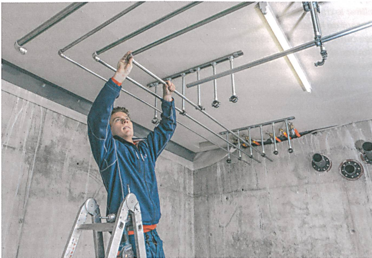
Dominic van Deuren montiert Rohre im System «Optipress-Aquaplus». | Dominic van Deuren monte les tubes du système Optipress-Aquaplus.
