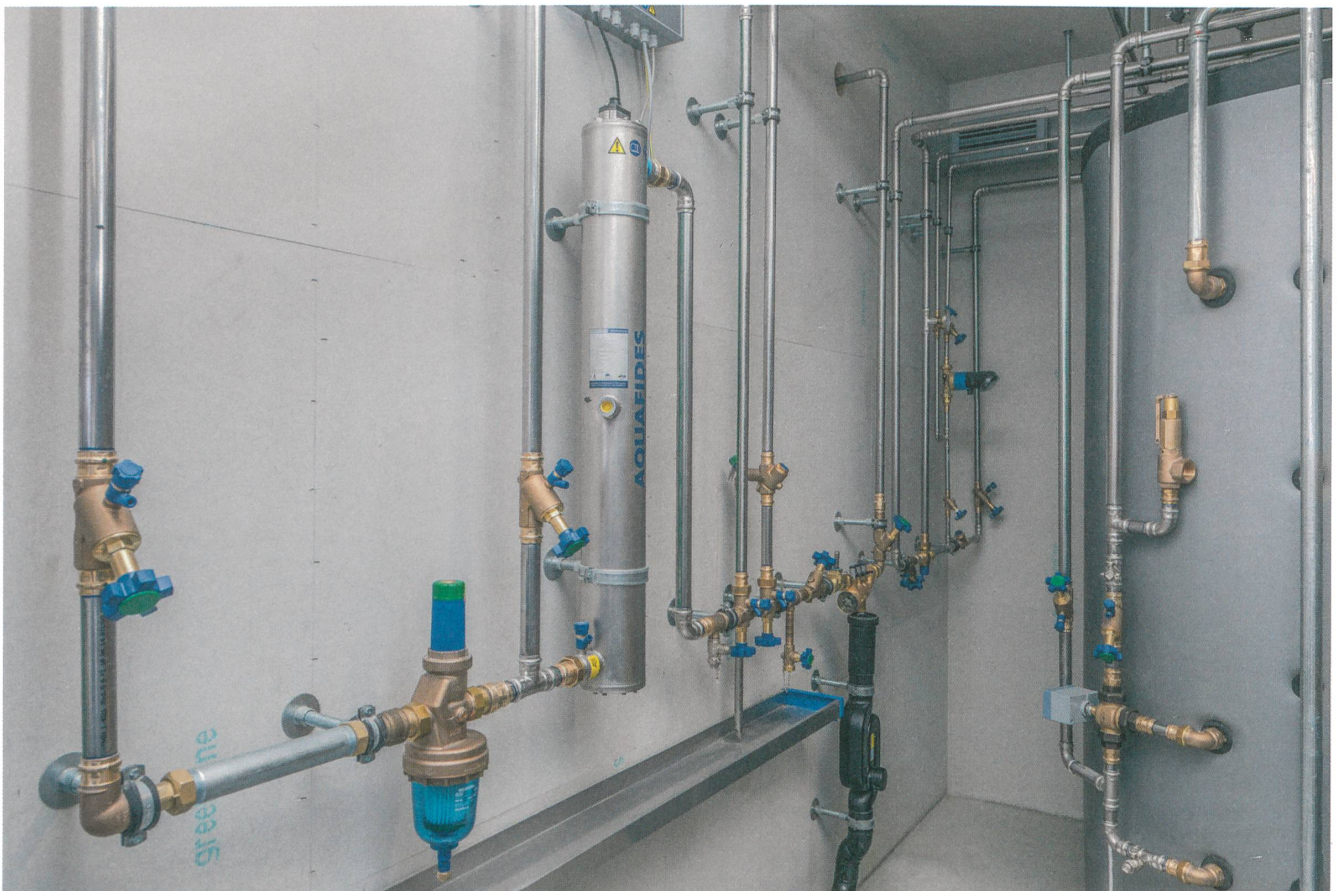
Das Herzstück: Wasser filtern, reduzieren, sichern und verteilen. | La pièce maîtresse: filtrer, réguler, assurer et distribuer l'eau.
