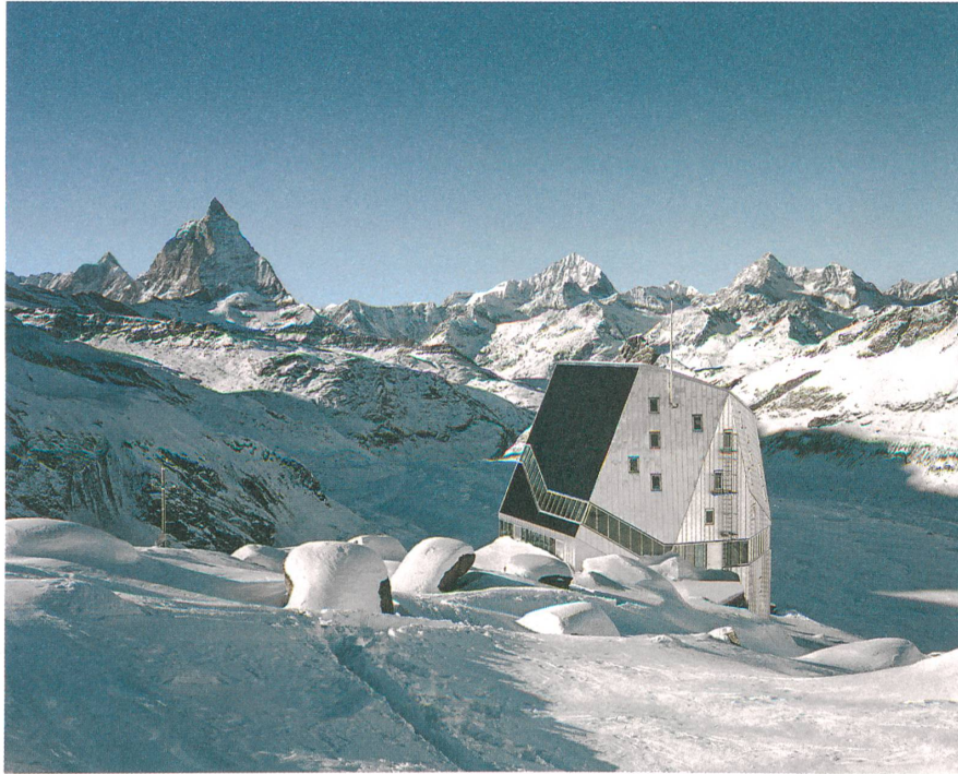
Mit umlaufender Kaskadentreppe und Photovoltaikfassade ist die polygonal geschnittene Monte-Rosa-Hütte Monument und technisches Wagnis. | Avec son escalier périphérique en cascade et sa façade photovoltaïque, la cabane polygonale du Mont-Rose est à la fois monument et pari technique.
