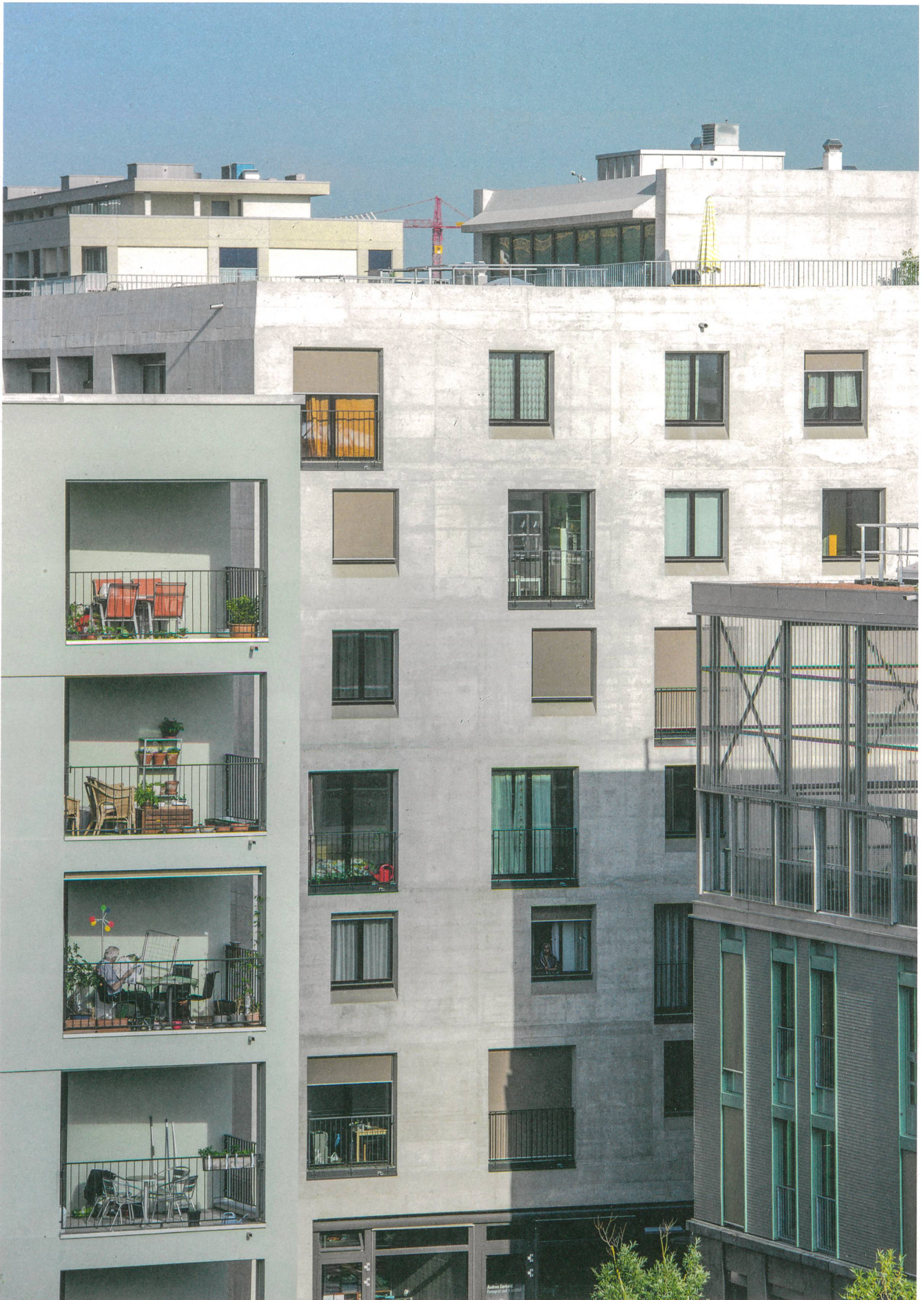
Auf dem höchsten Haus des Hunziker-Areals steht eine Sauna allen Bewohnerinnen und Bewohnern offen.
