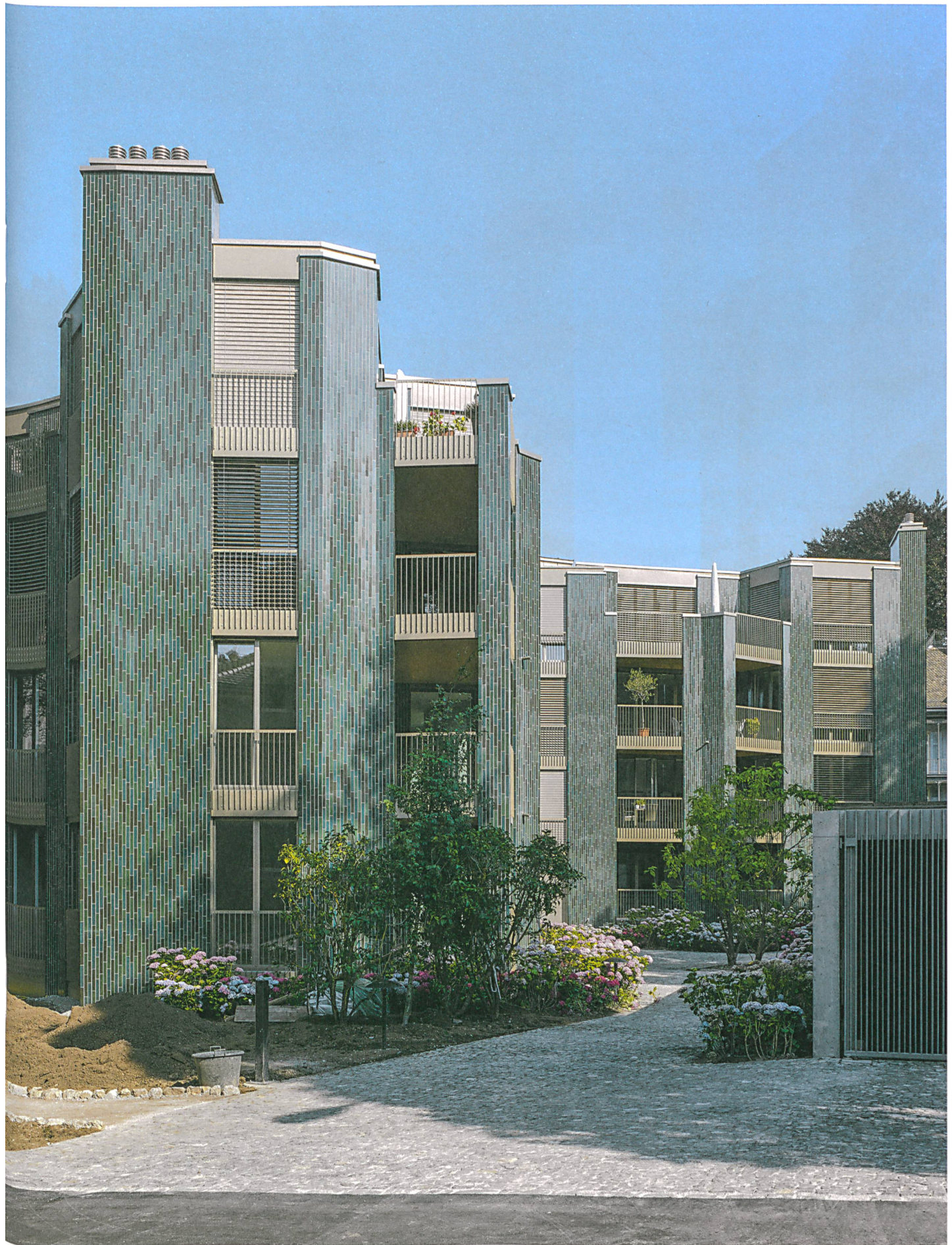
Das Grüne Haus in Zürich-Hottingen verschwindet in den Bäumen und es integriert die Kamine und die Drittelsregel im Attikageschoss.
