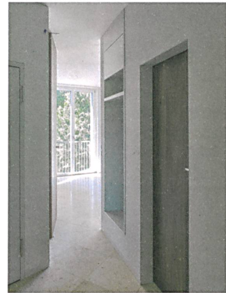
Tiefe Türen mit filigranen Metallzargen trennen die Zimmer vom Wohnraum im Grünen Haus.
