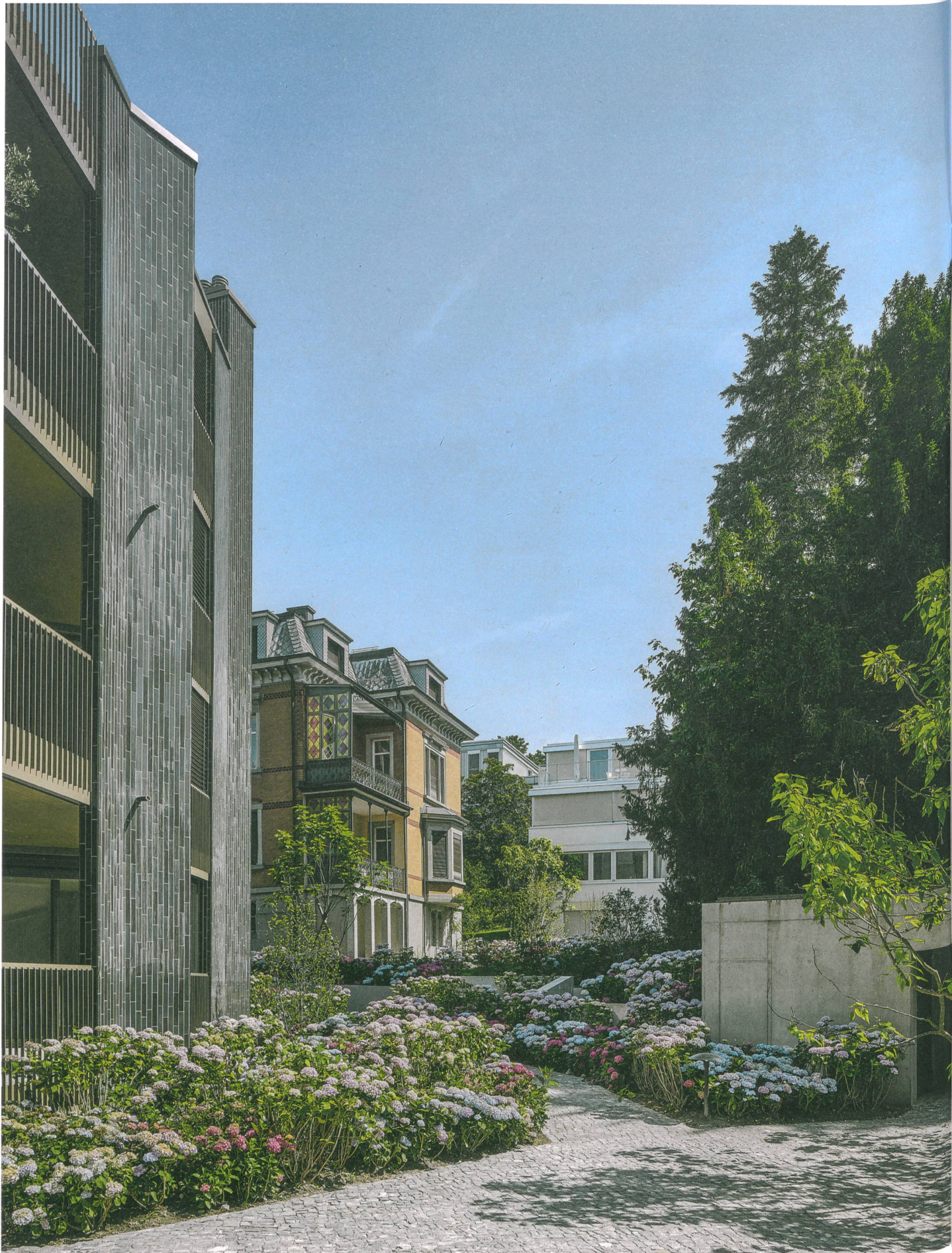
Das Grüne Haus, die umgebaute Gründerzeitvilla und das von der Frühmoderne inspirierte Atelierhaus stricken die Vielfalt im Zürcher Quartier Hottingen weiter.
