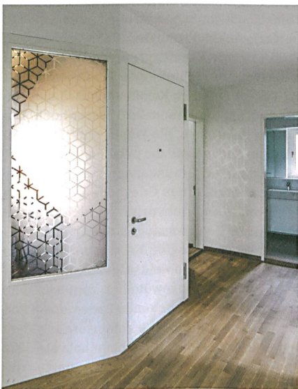
Villa: Neue Türen mit Ätztglas trennen das Treppenhaus von den neuen Geschosswohnungen. Sie lassen Licht, aber keine Blicke durch.
