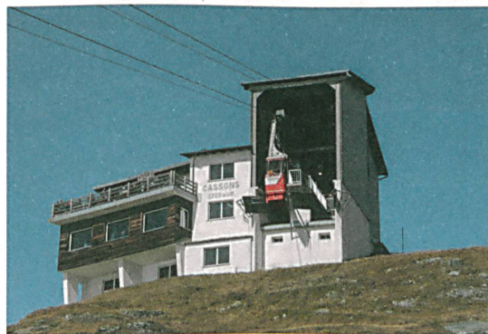
Bergbahn, Bergstation, Talstation – die Cassonsbahn ist integral zu erhalten.
