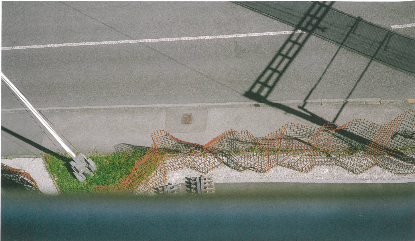
Statisch-bewegt: Von oben scheinen die fix einbetonierten Armierungseisen wie ein Seidentuch im Wind zu flattern.
