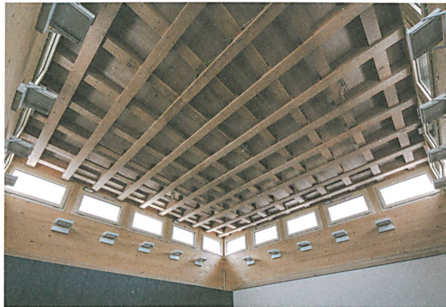
Dank Streifen aus Buchenholz trägt die Decke in zwei Richtungen. Fotos: ETH Zürich, Marco Carocari
