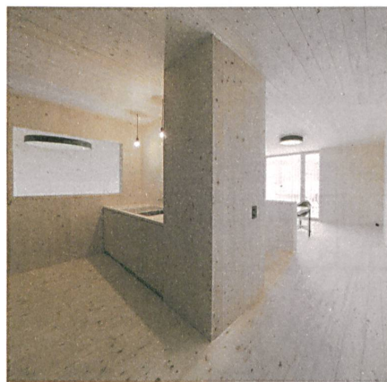
Der Bürokubus ist mit Massivholzelementen konstruiert.
