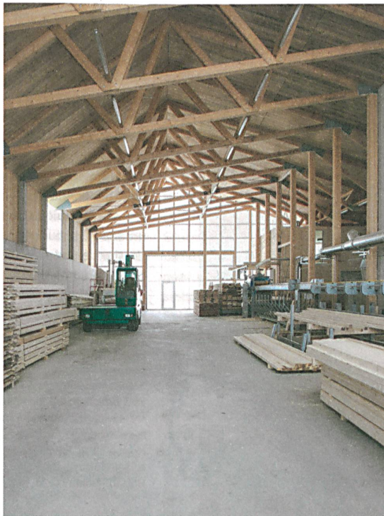
Kräftige Fachwerkträger überspannen die zweischiffige Halle.
