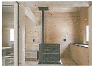
Geheizt wird mit einem Specksteinofen.
