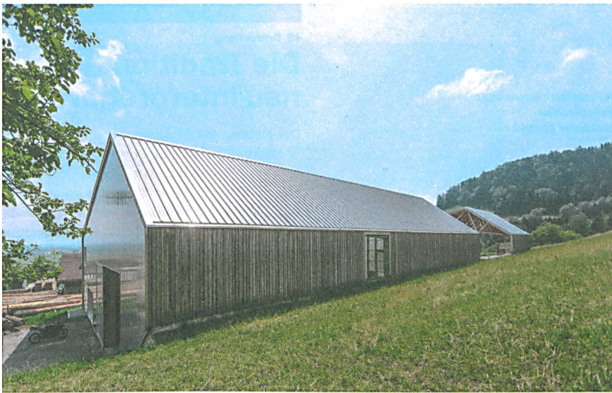
Das Satteldach passt die beiden Neubauten in die Landschaft ein.
