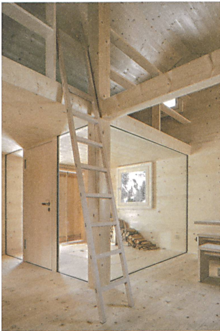
Eine Stütze teilt den Raum in vier Quadrate auf.
