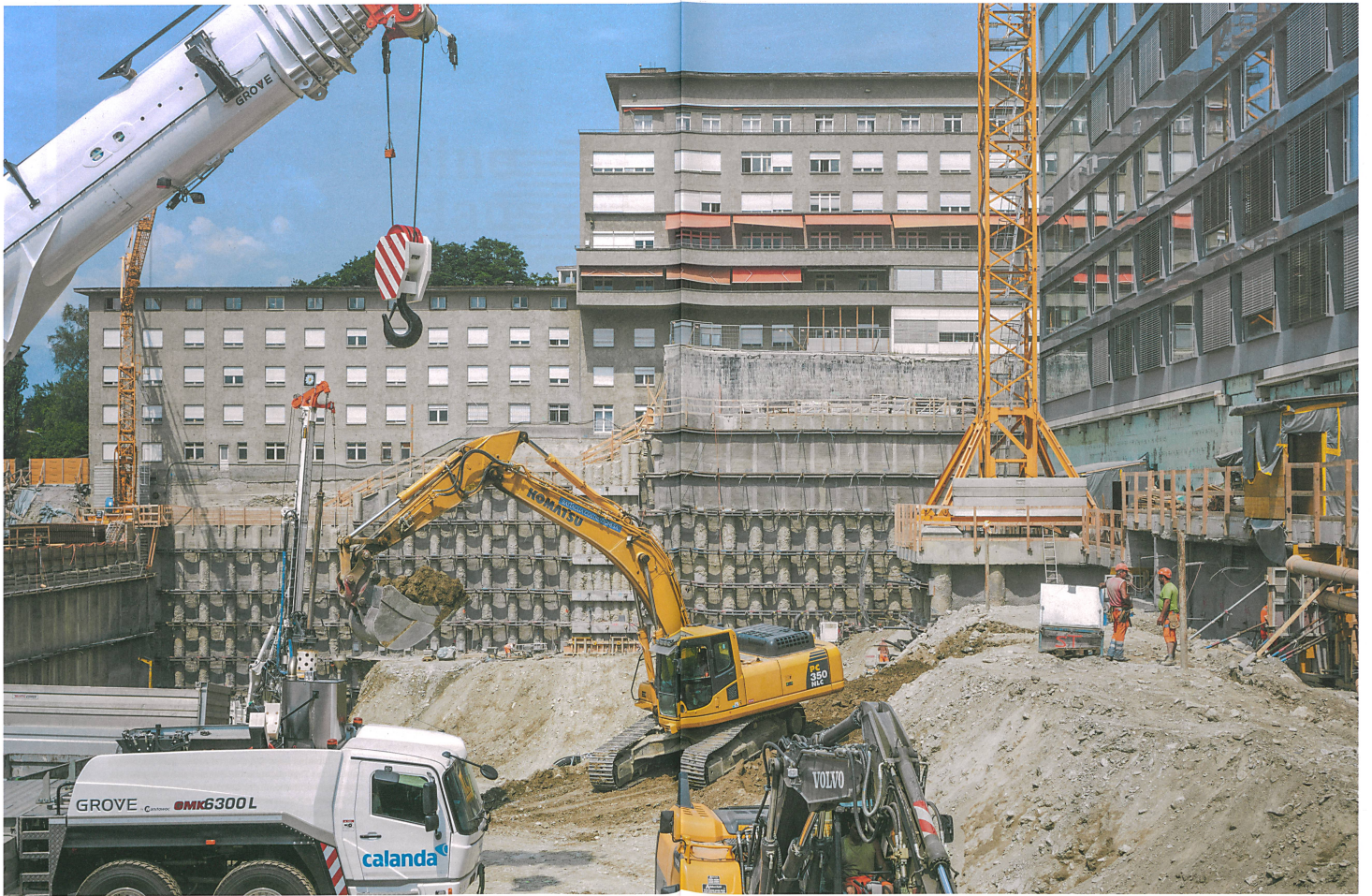
Es war Churs größte Baugrube. Daraus wächst das neue Kantonsspital Graubünden.
