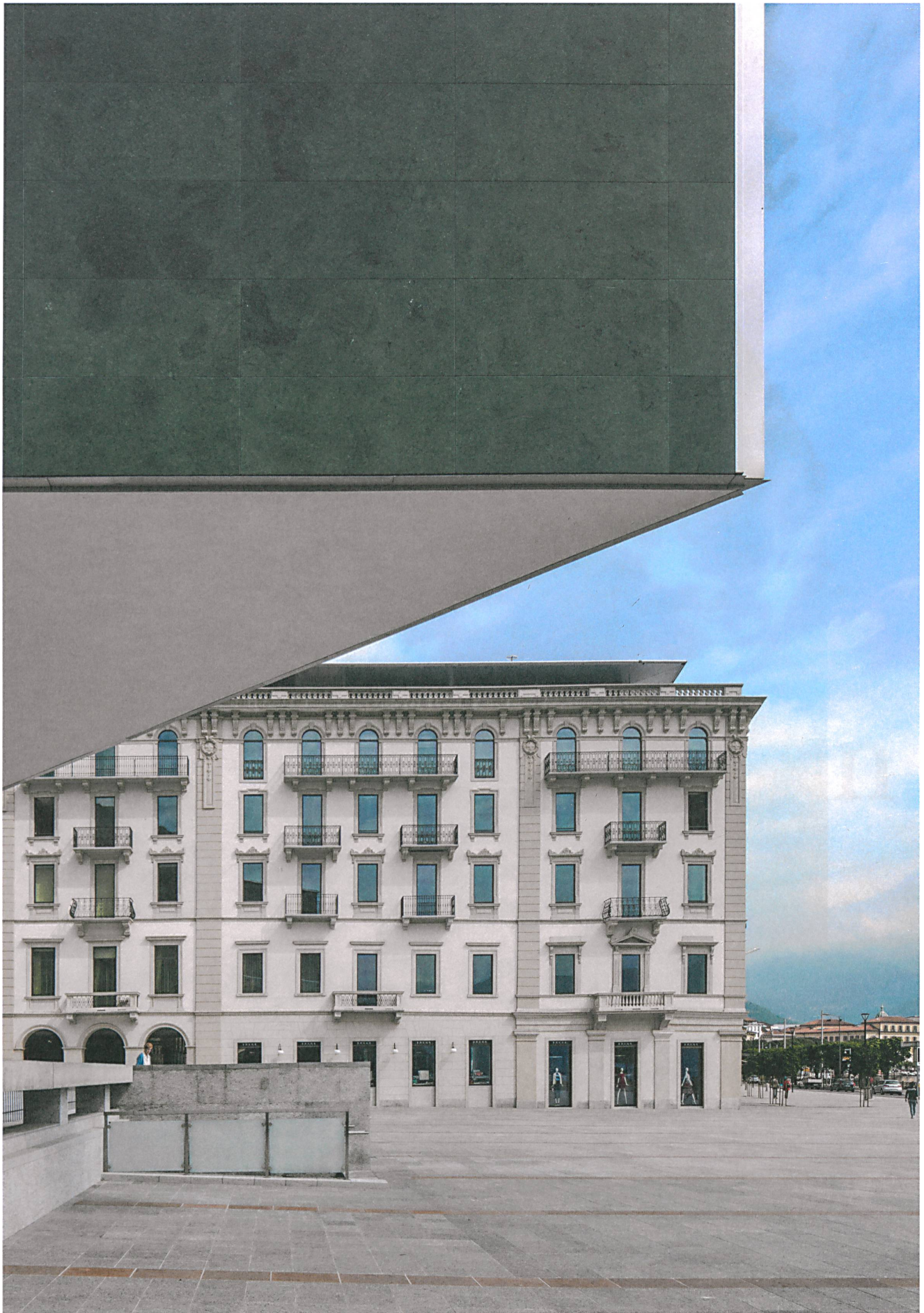
Das ehemalige Grandhotel Palace bildete den Ausgangspunkt für die Planung des LAC. Hinter der einstigen Hotelfassade verbirgt sich ein Neubau.
