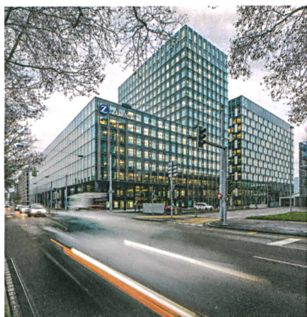
Skykey an der Hagenholzstrasse in Zürich ist eine Bürostadt im Haus: 2500 Arbeitsplätze finden auf 40 000 Quadratmetern Platz.
