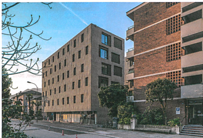
Zur Strasse gibt sich die Backsteinhaut der Wohnüberbauung in Locarno verschlossen.
