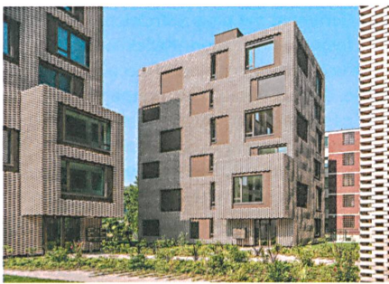
Die Ziegelhaut und die Kompaktfassade darunter stimmen absichtlich nicht genau überein.
