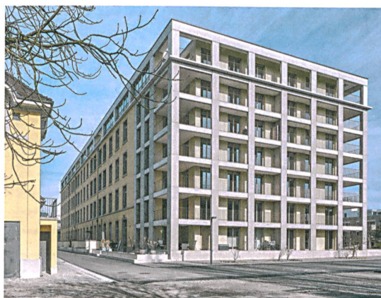
Der südliche Anbau hat sieben Geschosse, der aufgestockte Altbau fünf.
