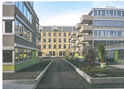
Das geübte Auge sieht: Die Fassaden tragen nicht.
