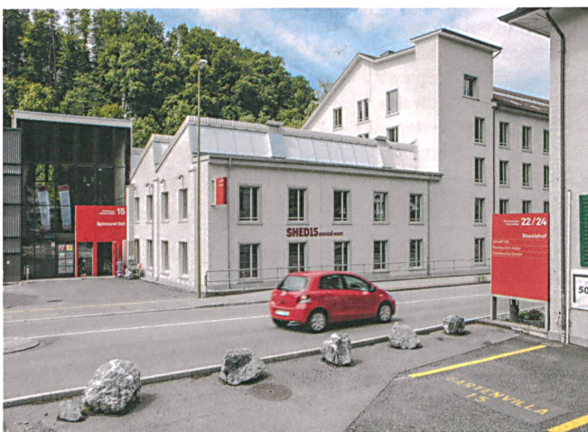
Der Shedbau von 1918 schmiegt sich an das Spinnereigebäude von 1862.
